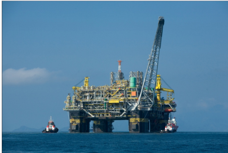
Figura 30 - Plataforma semi-submersível P51 sendo rebocada. Fonte: http://agenciabrasil.etc.com.br .
