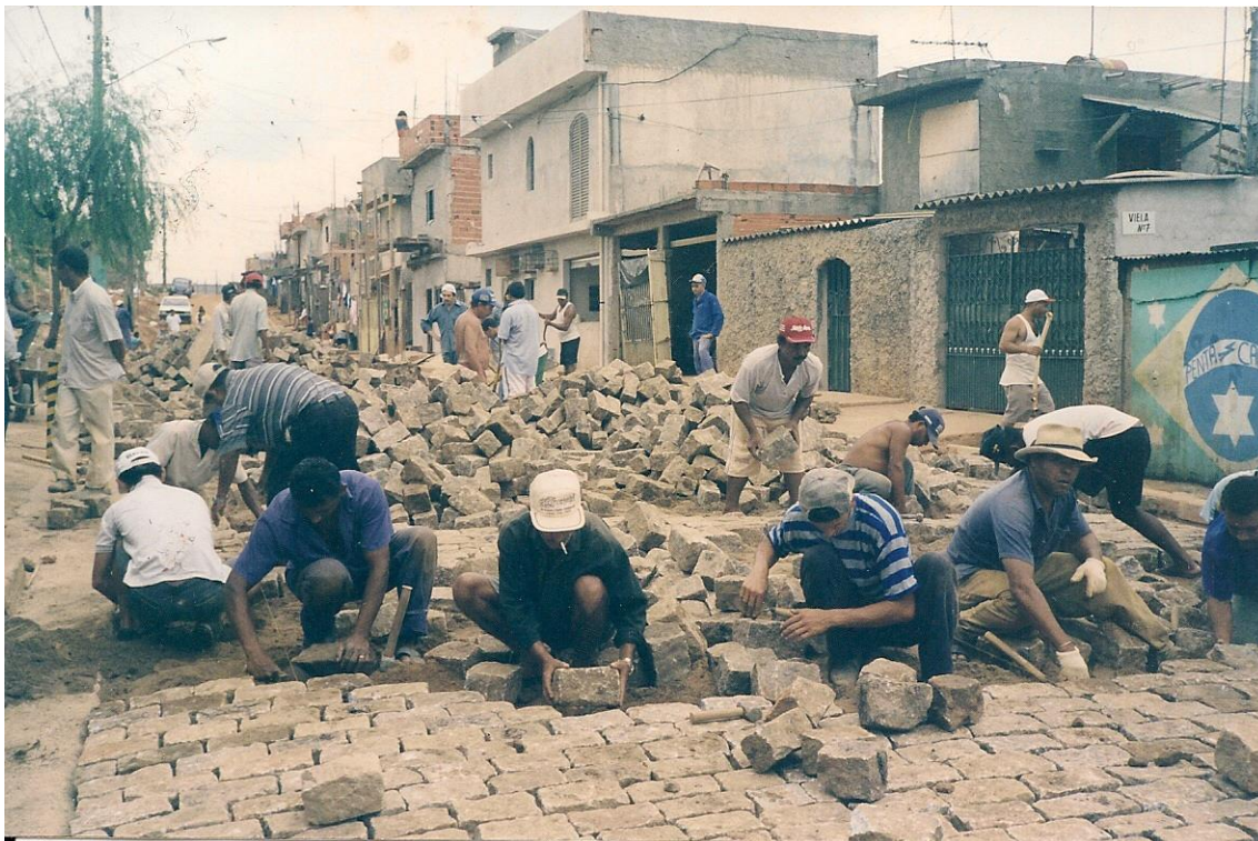
Figura 32: Mutirão dos moradores para assentamento de blocos na rua
