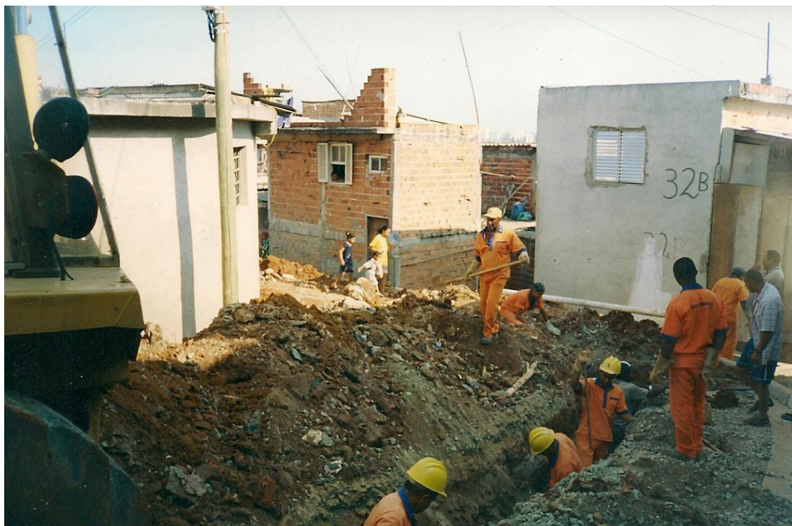
Figura 29: Funcionários da prefeitura instalando sistema de saneamento básico no Quilombo II
