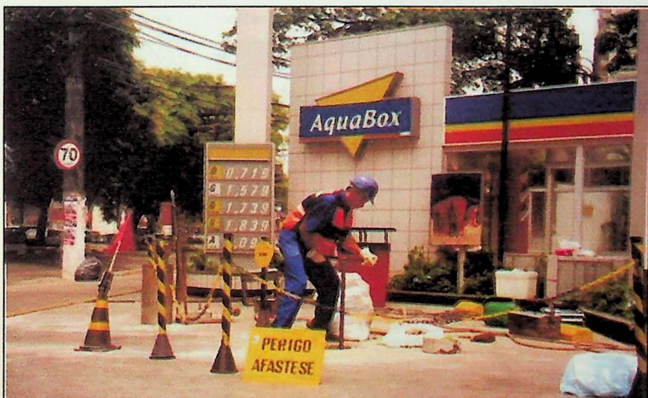
Figura 8 - Instalação de poço de monitoramento.
