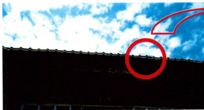
Telhado do galpão
