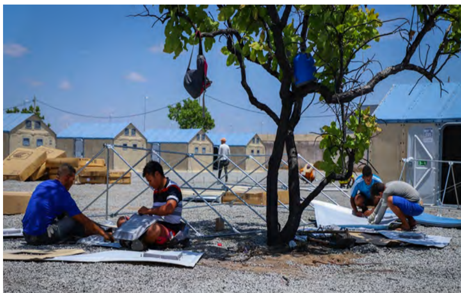
Figura 8: Montagem da estrutura do abrigo Better Shelter em Boa Vista, Roraima. (Fonte: Exército Brasileiro)
