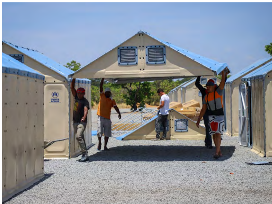
Figura 9: Montagem da cobertura do abrigo Better Shelter em Boa Vista, Roraima. (Fonte: Exército Brasileiro)
