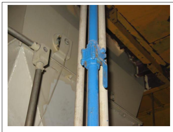
Figura 56: Válvula de Bloqueio da Alimentação do Ar Comprimido.
