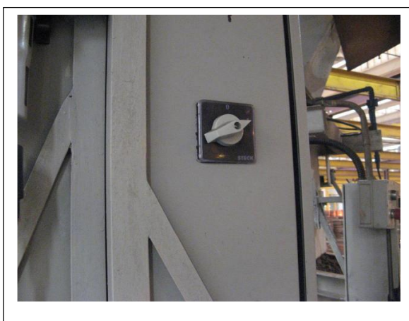
Figura 55: Chave Seccionadora
