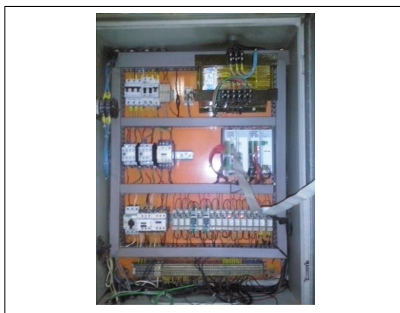
Figura 30: Painel de Comando Elétrico
