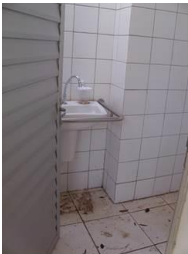
Figura 18 - Banheiro de servidores e usuários na sede da FEP Vegetal. Fonte: Arquivo pessoal.
