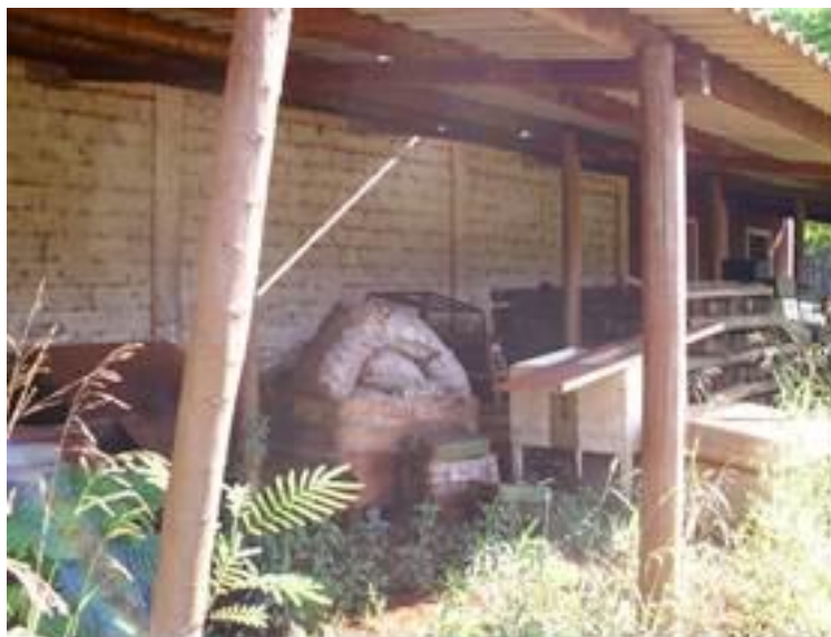
Figura 11 - Arranjo inadequado e acúmulo de inservíveis na FEP Vegetal.
