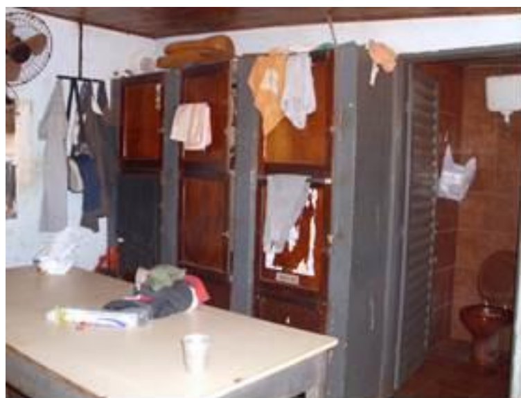
Figura 16 - Vestiário e banheiro da oficina para servidores na FEP Vegetal.
