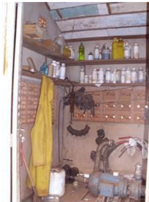
Figura 29 - Armazenamento inadequado, em casa de bomba de irrigação, na FEP Horticultura / Zootecnia.
