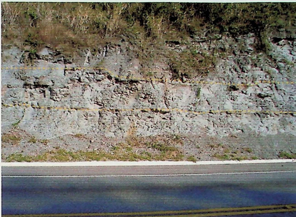
Foto 9 – Visão geral do afloramento com continuidade lateral, destaque a estrutura.
