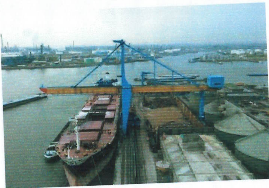
Fig.. 4 – Visão do Terminal E.B.S de Rotterdam
