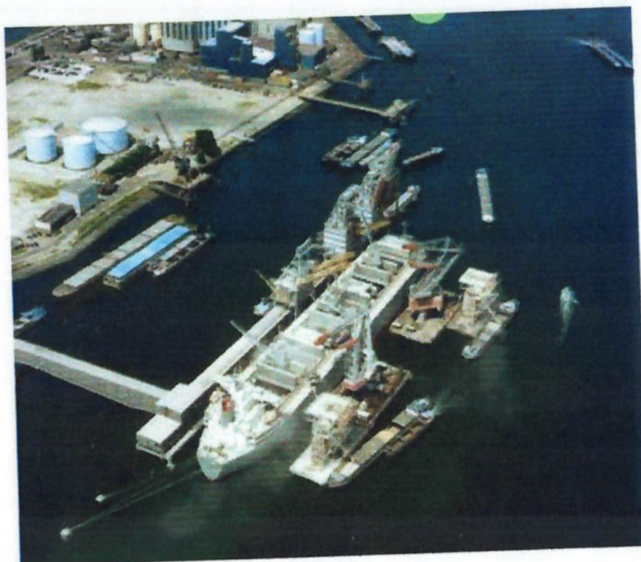
Fig. 6 – Visão do Terminal 2 E.B.S de Rotterdam
