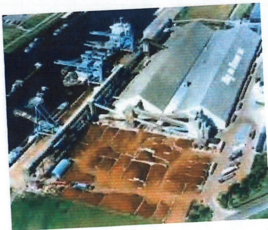
Fig. 10 – Visão do Terminal de Verbrugge
