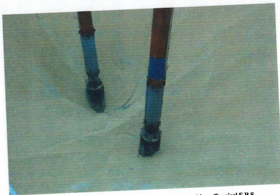
Fig.. 26 – Visão do descarregamento de grãos com equipamento pneumático – Terminal E.B.S.
