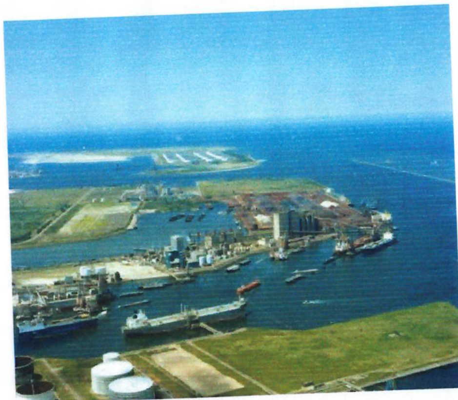
Fig.. 5 – Visão do Terminal E.B.S de Rotterdam
