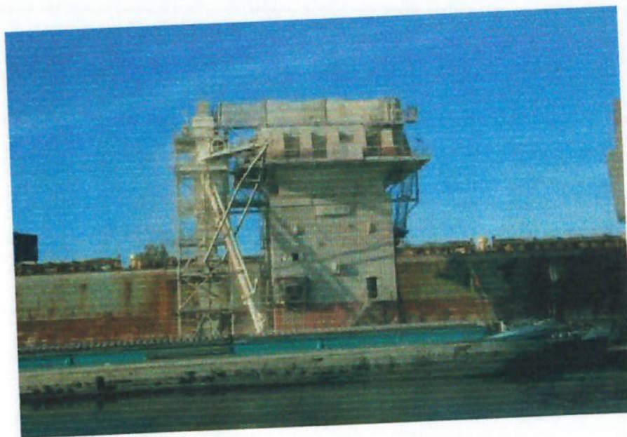
Fig.. 30 -- Ponte de Balança de Fluxo
