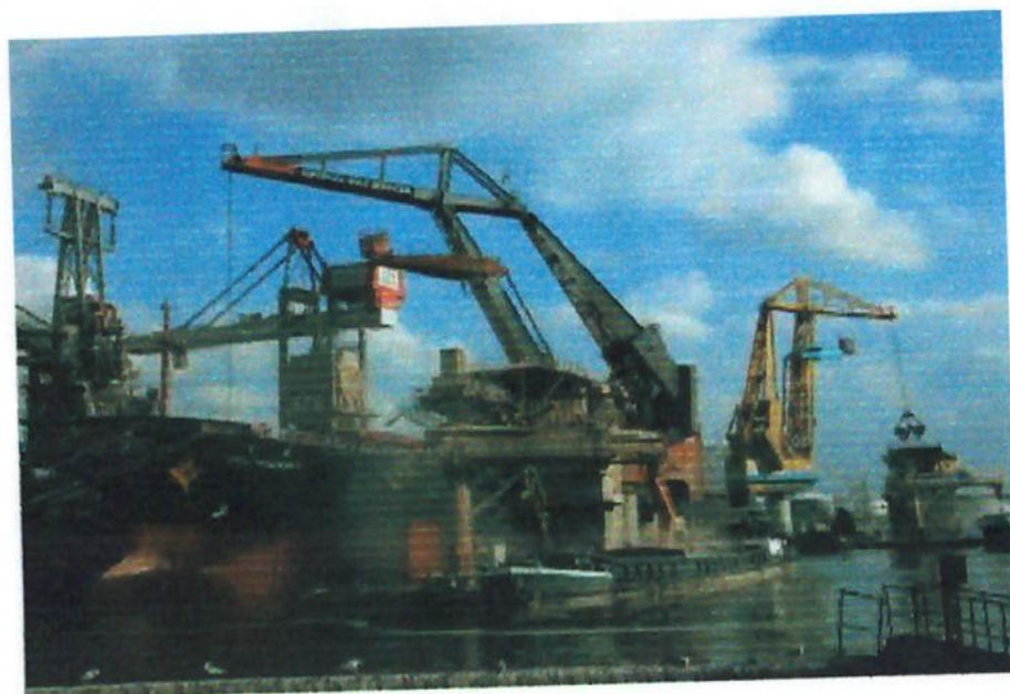
Fig.. 19 – Visão da operação de Guindastes com grab (36 tons) – Terminal E.B.S.
