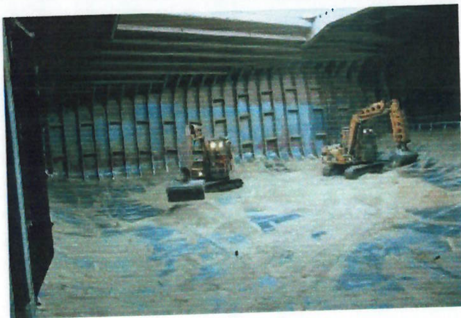
Fig.. 28 – Visão da máquina de recheio no porão do navio – Terminal E.B.S.
