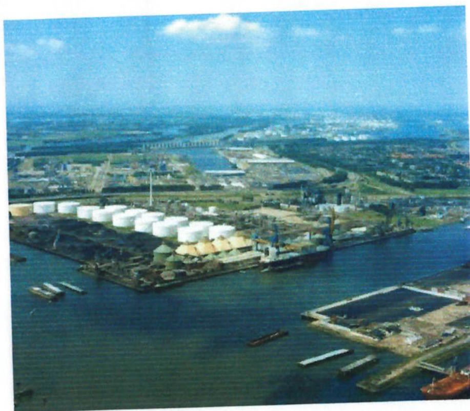
Fig. 7 – Visão do Terminal E.B.S de Rotterdam
