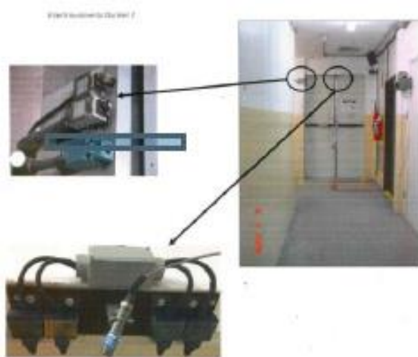
Figura 14 – Sistema de intertravamento do bunker número 2
