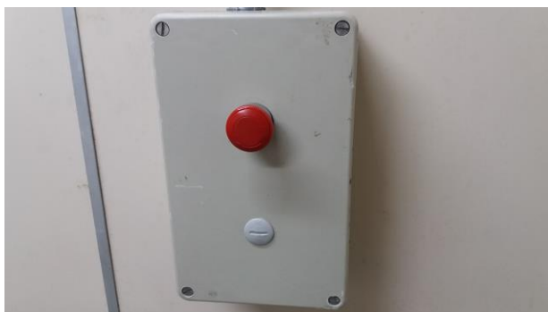
Figura 18 – Botoeira de emergência localizada dentro do bunker 1
