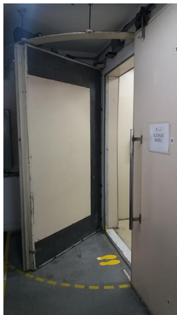
Figura 20 – Blindagem da porta e paredes no bunker 1
