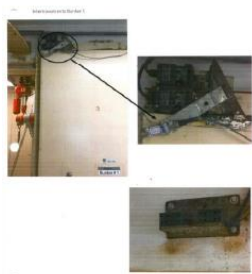
Figura 15 – Sistema de intertravamento do bunker número 1
