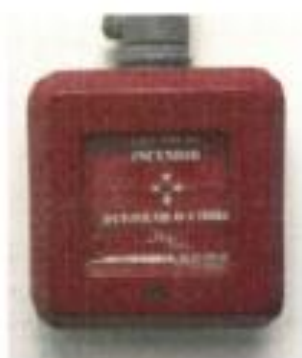
Figura 19 – Botoeira de emergência da unidade de radiografia industrial
