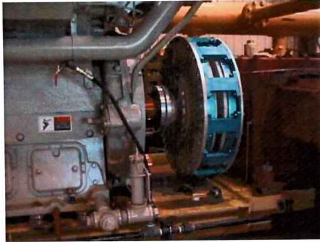
Figura 7 - Exemplo de aplicação do acoplamento magnético: compressor
