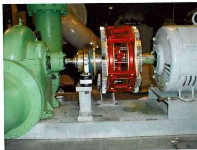
Figura 9 - Exemplo de aplicação de acoplamento magnético: bomba hidráulica
