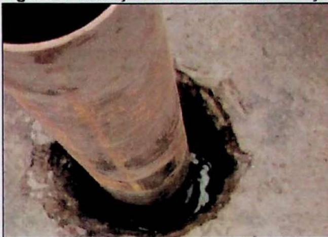
Figura 8 - Inserção do revestimento de aço.
