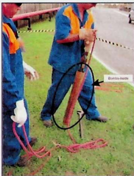
Figura 9 - Equipamento utilizado para retirada de material inconsolidado
