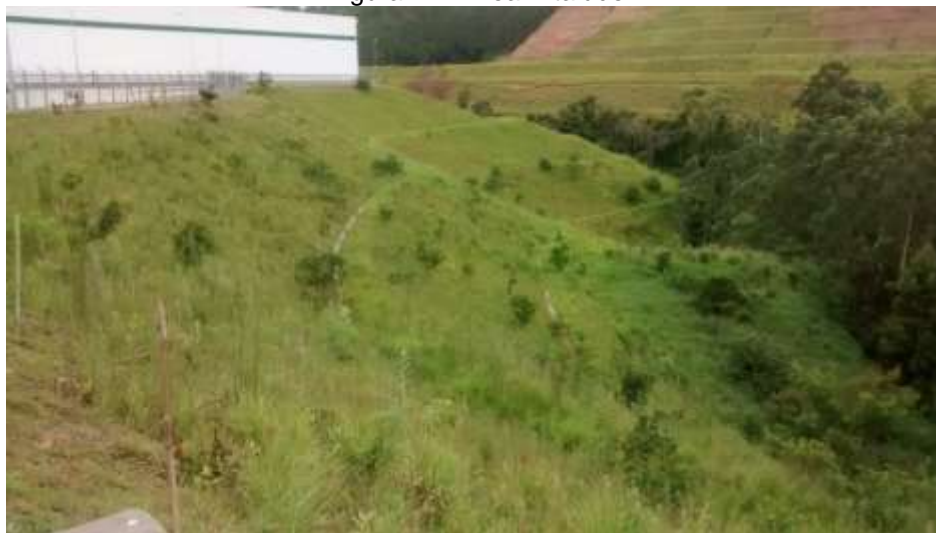
Figura 12 - Área B talude
