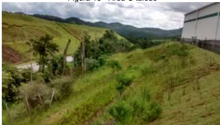
Figura 15 - Área C talude
