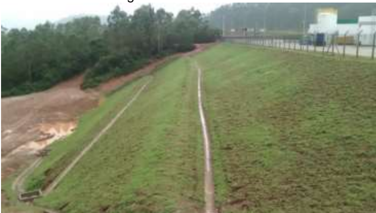
Figura 17 - Área D talude
