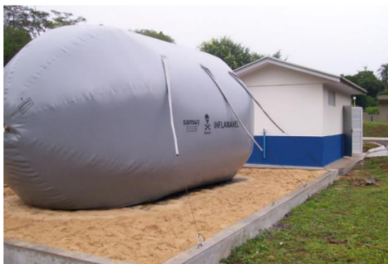
Figura 2.13 – Gasômetro de armazenamento do biogás da ETE Ouro Verde.
