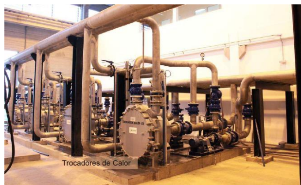
Figura 2.15 – Trocadores de calor do sistema de cogeração da ETE Arrudas – COPASA-MG.
