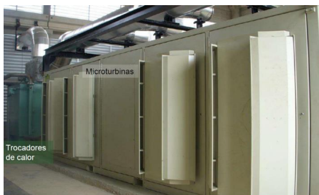
Figura 2.14 – Microturbinas do sistema de cogeração da ETE Arrudas – COPASA-MG.
