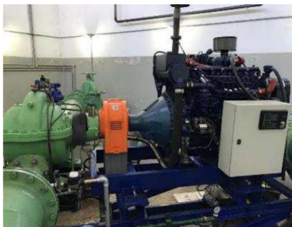
Figura 2.10 - Projeto piloto para o bombeamento de água utilizando motor a gás natural
