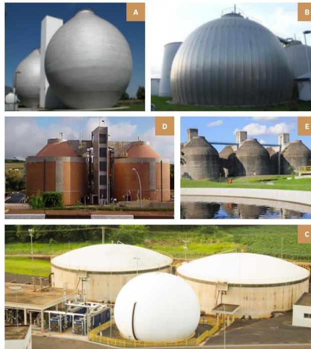
Figura 2.4 - Diferentes tipos de digestores de lodo
