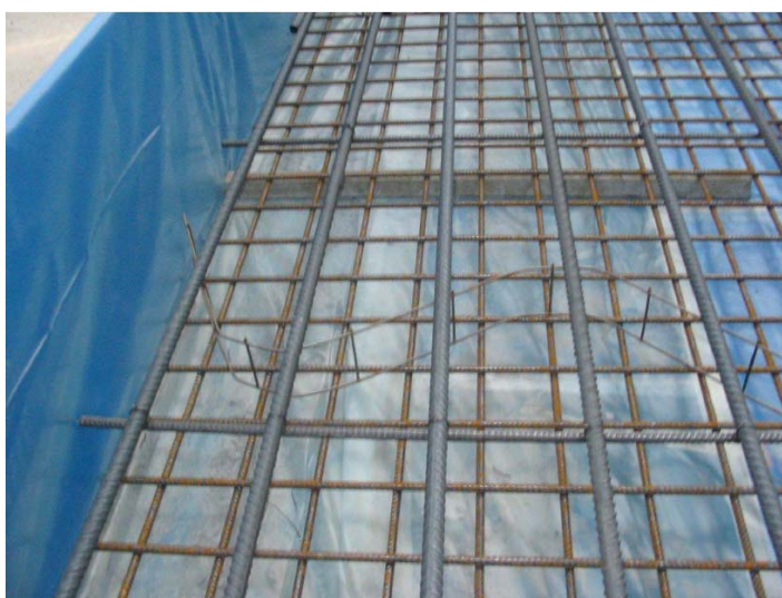
FIGURA 72 - ARMADURAS JÁ ARRANJADAS – FONTE: FEBELCEM
