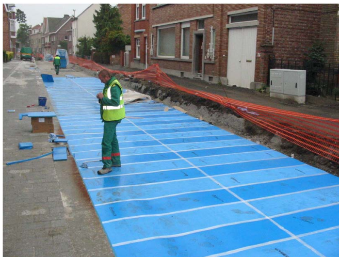
FIGURA 71 - APÓS PREPARO DE BASE E SUB-BASE É FEITO O TRATAMENTO CONTRA VIBRAÇÕES
