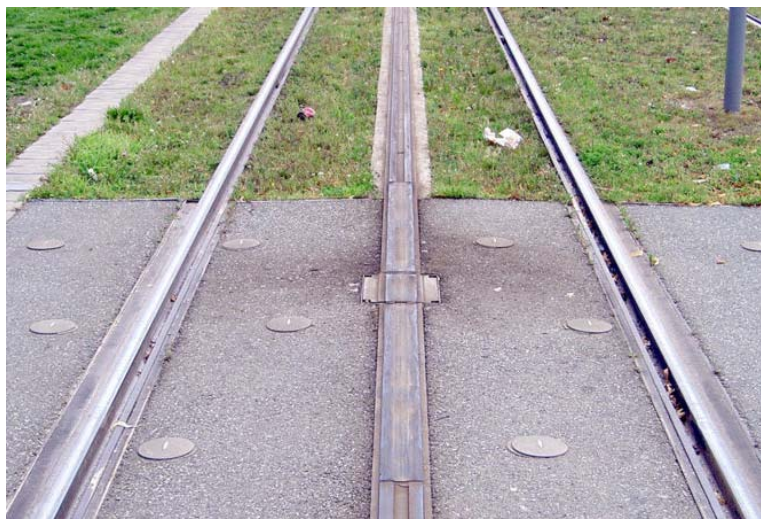
FIGURA 83 - ALIMENTAÇÃO POR TERCEIRO TRILHO - FONTE: WIKIPEDIA
