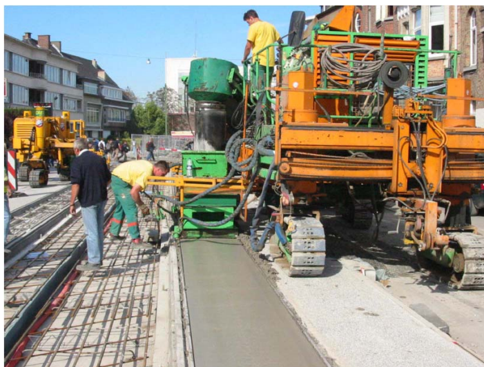
FIGURA 76 - CONCRETAGEM DA SEGUNDA CAMADA DE CONCRETO – FONTE: FEBELCEM
