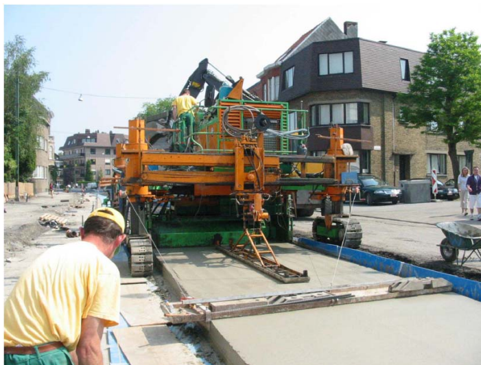
FIGURA 74 - CONCRETAGEM DA LAJE ONDE SERÃO APOIADOS OS TRILHOS- FONTE: FEBELCEM
