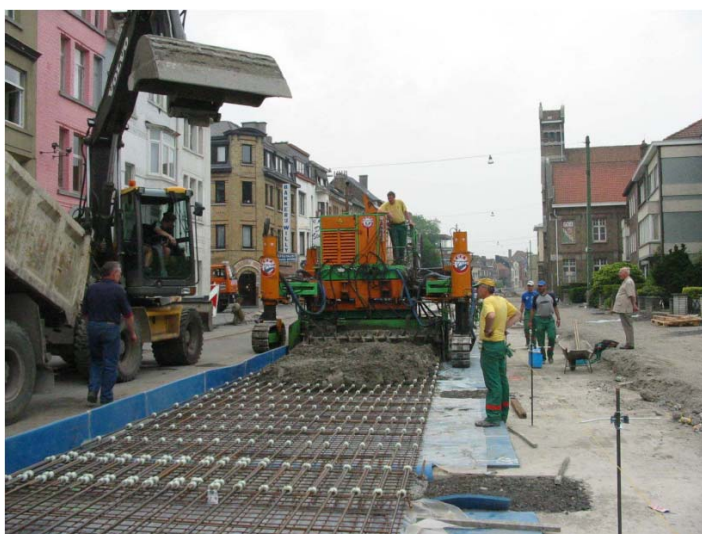
FIGURA 72 - ARMADURAS JÁ ARRANJADAS – FONTE: FEBELCEM
