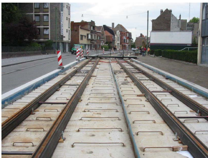
FIGURA 74 - CONCRETAGEM DA LAJE ONDE SERÃO APOIADOS OS TRILHOS- FONTE: FEBELCEM
