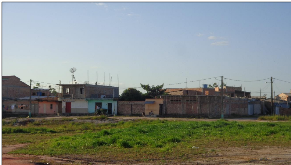
Figura 31: Casas no bairro Frei Calixto a menos de 1 Km do Outeiro da Glória. As casas são construídas com tijolos e o uso de vidro é restrito a pequenas janelas. As ruas ainda não possuem asfaltamento. Autora: Juliana Marin dos Santos 24/10/2016
