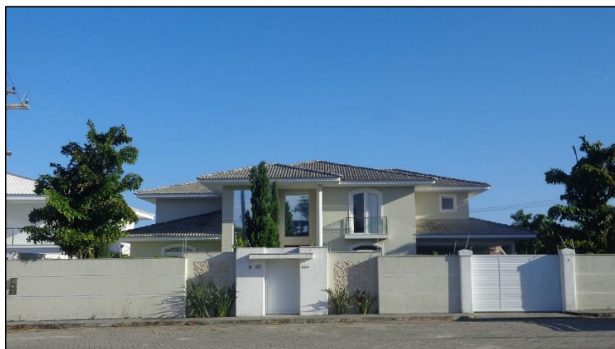
Figura 29: Casa no Outeiro da Glória, com arquitetura bem diferente da utilizada por moradores. Além da utilização de grandes portas e janelas de vidro destaca-se o uso de plantas exóticas como o cipreste, normalmente presente em climas mais frios e secos. Apesar do controle de acesso e muros, a casa possui seu próprio sistema de segurança com cerca elétrica e câmeras de vigilância. Autora: Juliana Marin dos Santos 24/10/2016
