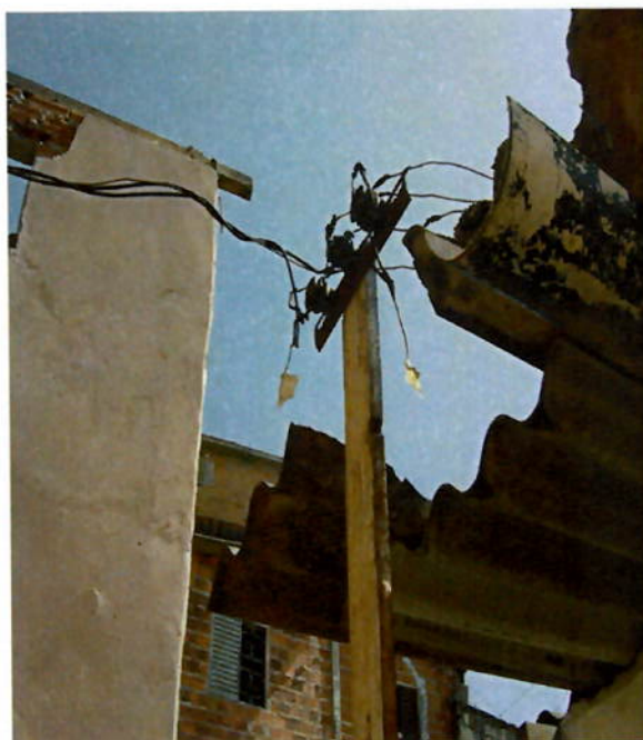
Figura 24 – Detalhe da ligação energia elétrica nas moradias
