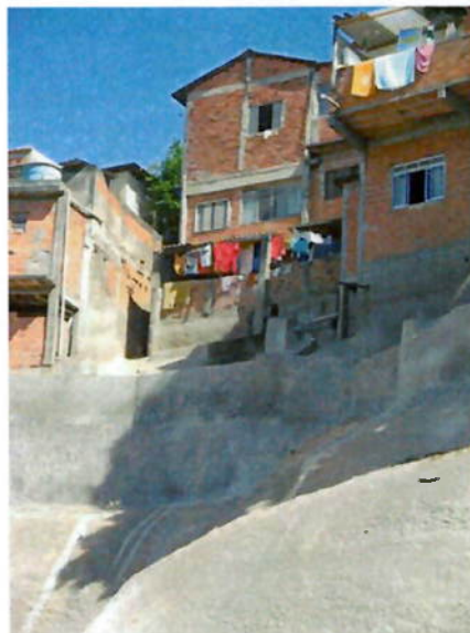
Figura 37 – Concreto projetado aplicado nas encostas mais íngremes
