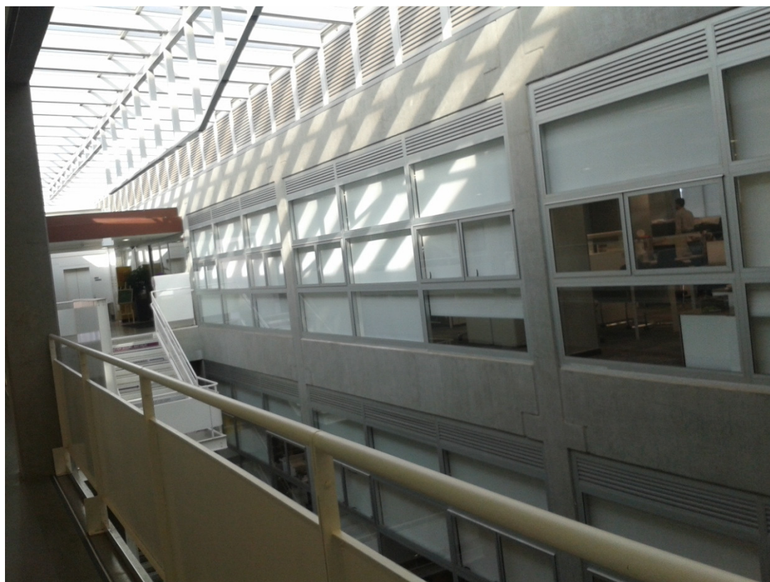
Figura 03 – Telhado zenital e iluminação natural em áreas internas
