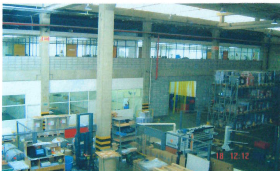
Figura 16 - Vista geral da área administrativa.
