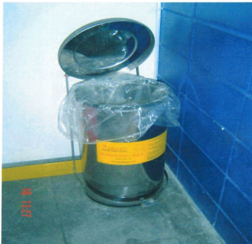
Figura 21 - Lixeiras corta-fogo / auto-extinguível.
