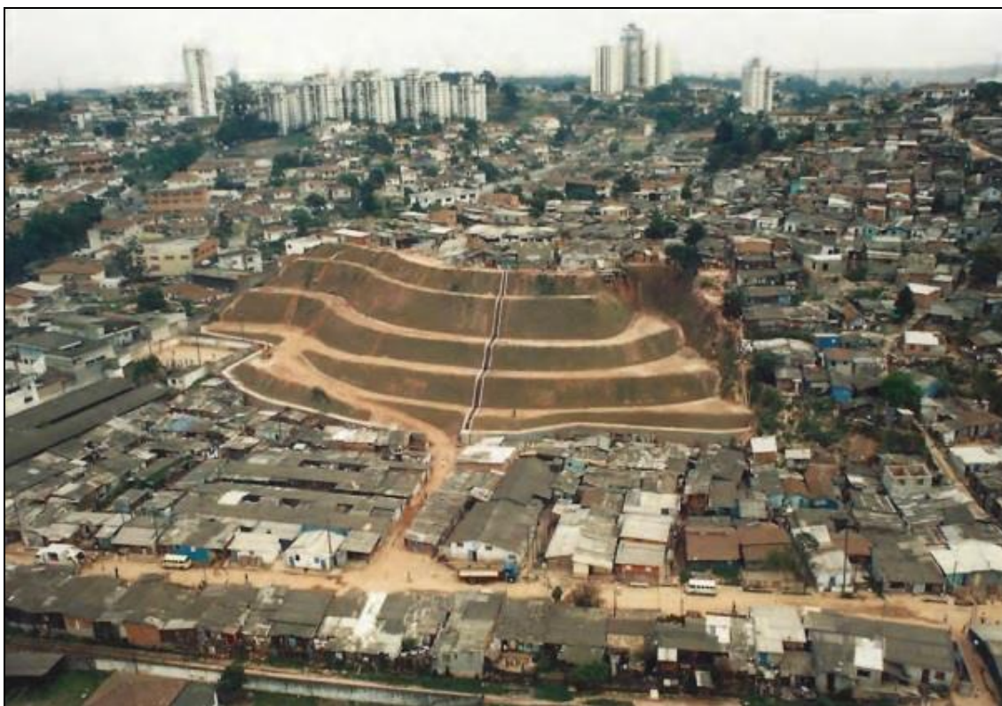
Figura 11 Área de risco após a obra de retaludamento. Fonte: Acervo PMSP, 1991 apud FACHINI (2014)
