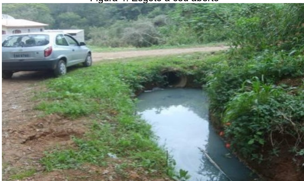
Figura 4. Esgoto a céu aberto
