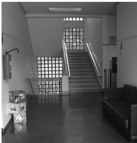
escadas de acesso ao primeiro pavimento do G.E Clóvis Beviláqua
