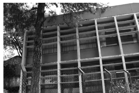
uso de brise-soleil em toda a fachada do G.E Clóvis Bevilacqua
