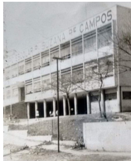
No G.E do Perus, não há o uso de brise-soleil na integralidade da fachada
