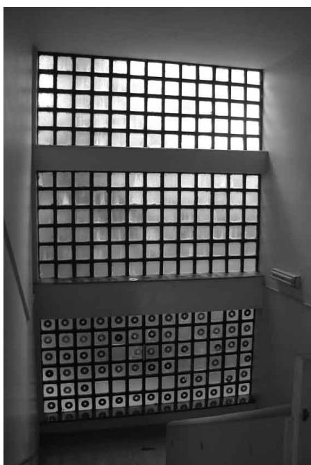
uso de elementos de vidro no G.E Clóvis Beviláqua para maximizar a luz natural sobre as escadas de acesso
