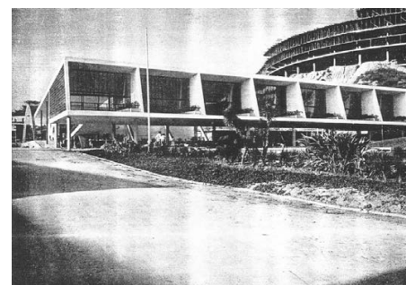
modulação estrutural presente na fachada da escola do Pedregulho, de Reidy
