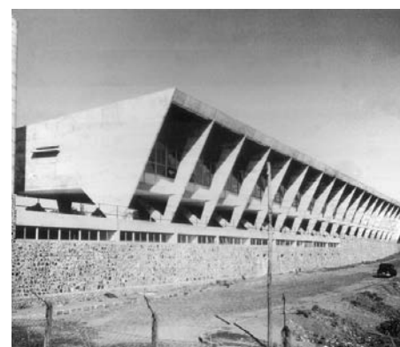
modulação estrutural presente na fachada do Colégio Brasil-Paraguai (1952), de Reidy
