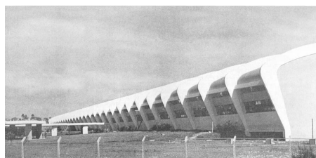
uso de pórticos de concreto na fábrica Dunchen, de Oscar Niemeyer
