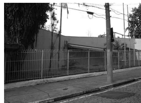
entrada e bloco administrativo da E.A da Água Branca.
