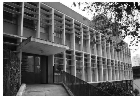
Entrada do G.E Clóvis Bevilácqua com destaque para a marquise atirantada
