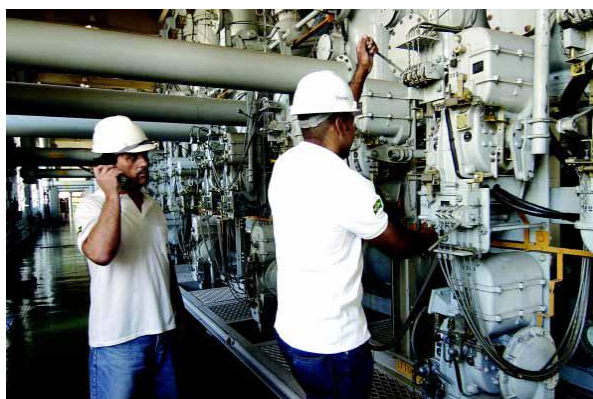
Figura 3- Manobra de chaveamento na subestação a SF 6 ; Grajaú - RJ (primeira instalação do Brasil).
