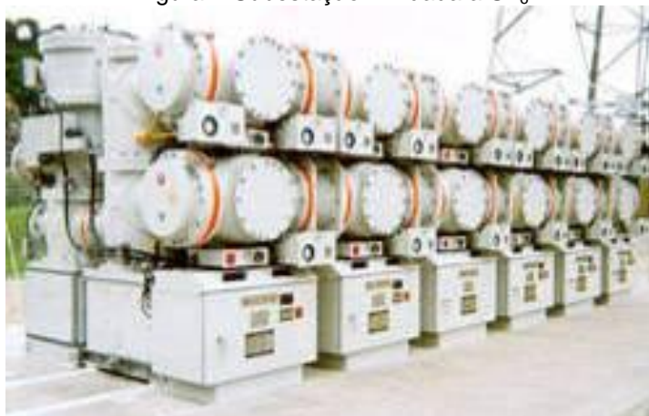
Figura 1-Subestação Blindada a SF 6
