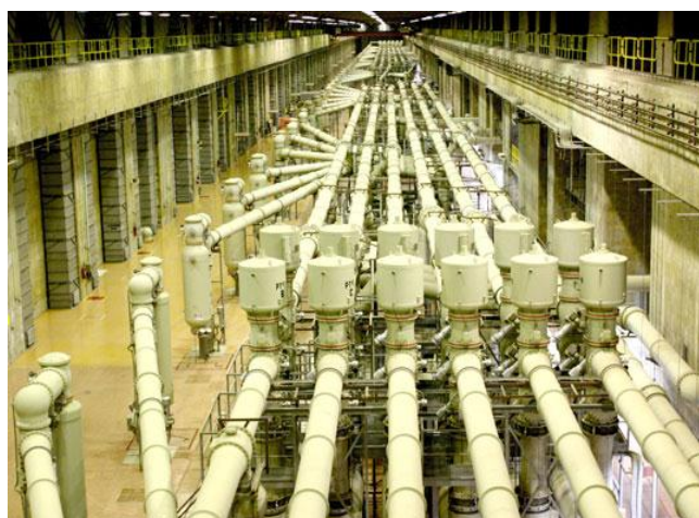
Figura 4- Estação de comutação da Usina de Itaipu, com mais de 100 toneladas de SF 6 .
