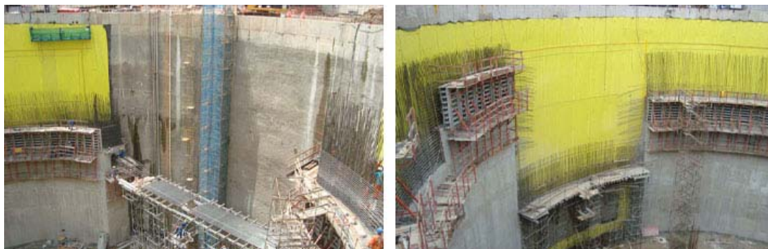
Figura 70 - Execução do revestimento secundário
