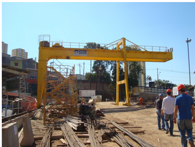
Figura 83 - Ponte rolante da Andrade Gutierrez
