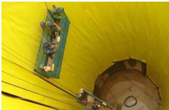
Figura 77 - Colocação e fixação da manta de impermeabilização
