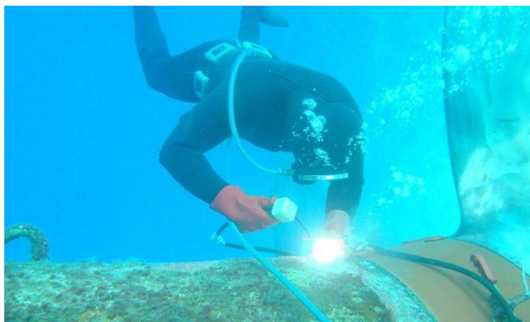
Figura 2 - Soldagem em grandes profundidades.
