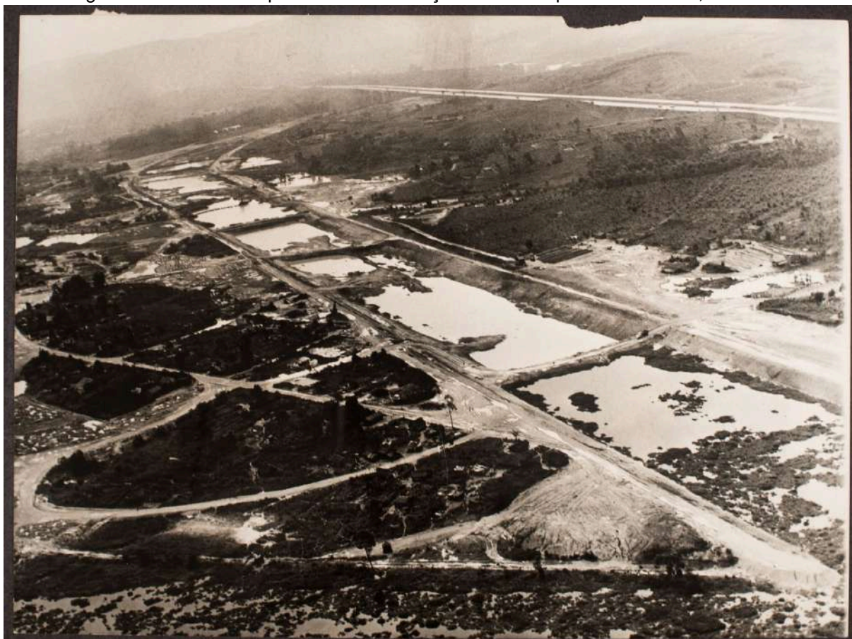
Figura 5.13 - Canal em processo de retificação entre Carapicuíba e Barueri, em 1972.
