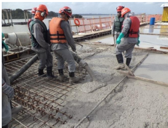
Figura 32: Lançamento do concreto com bomba, TERFRON
