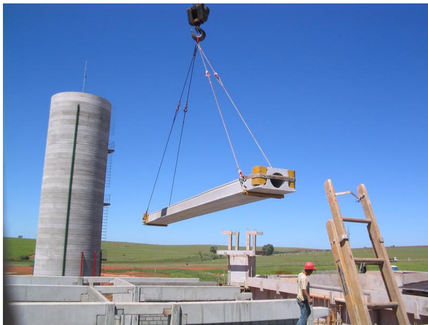
Figura 126: Içamento de peça pré-moldada sem balancim
