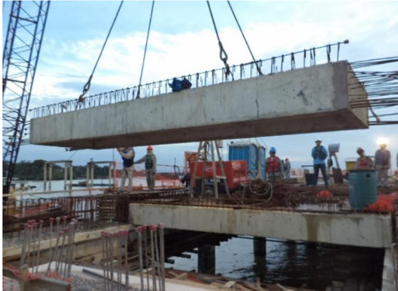
Figura 31: Lançamento da laje "pi" pré-moldada, TERFRON
