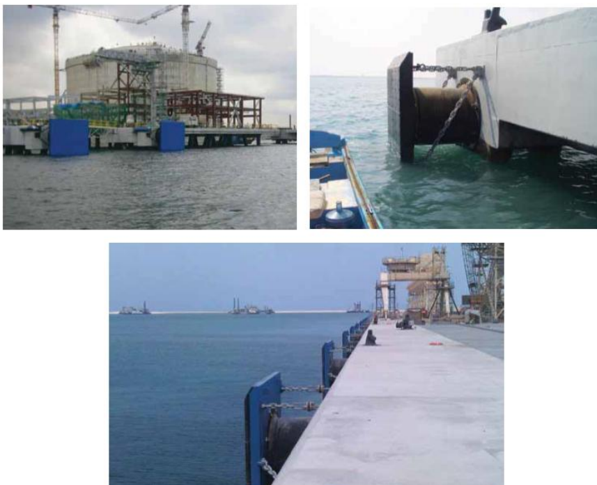
Figura 74: Defensas cilíndricas (Trelleborg)
