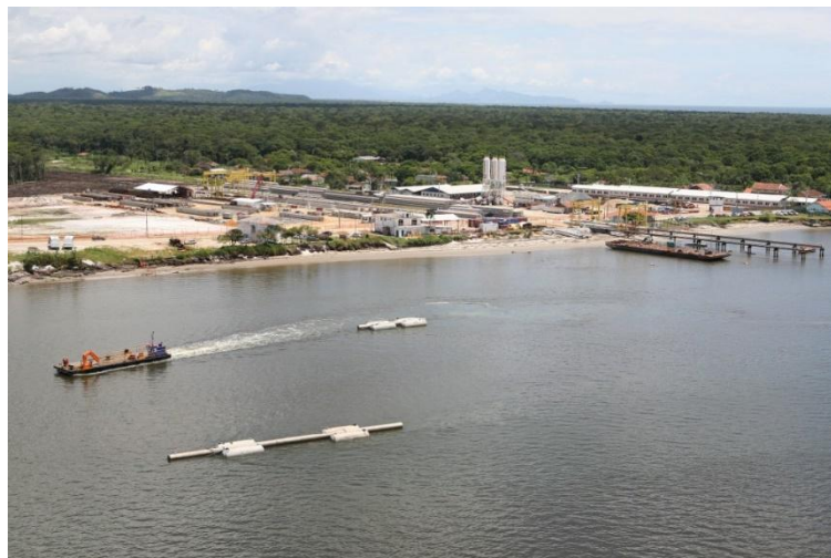
Figura 27: Estacas protendidas transportadas ao local de cravação por boias – Porto de Itapoá
