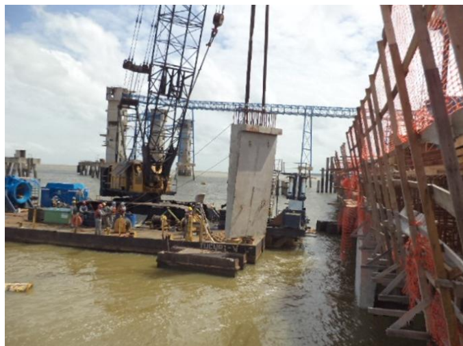
Figura 34: Lançamento do paramento da defesa
