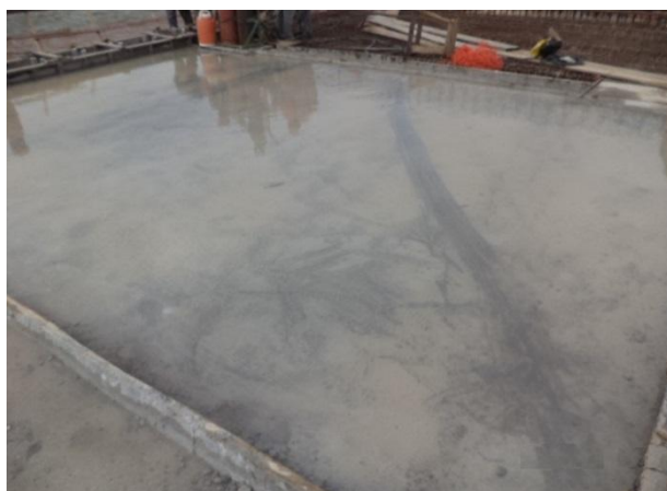
Figura 33: Cura do concreto com lâmina d'agua
