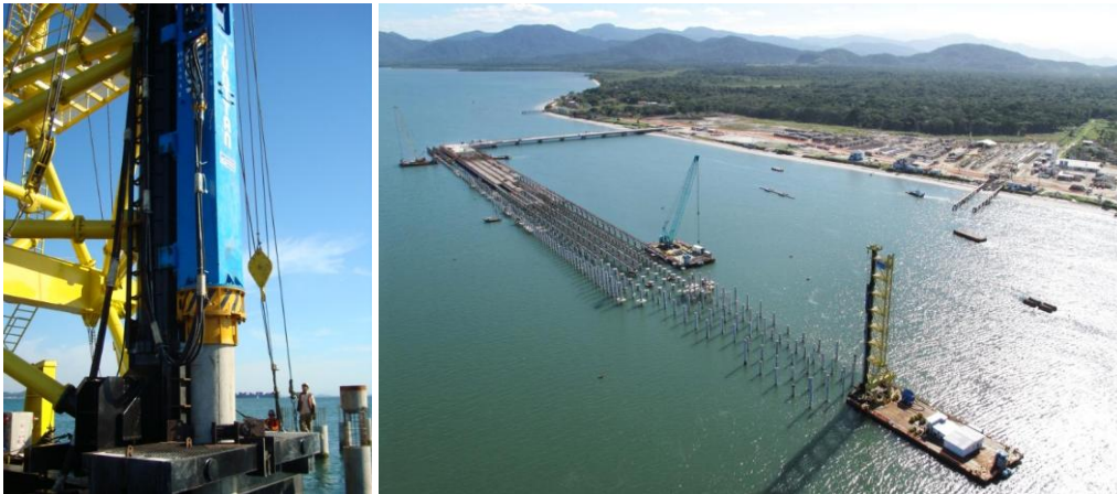
Figura 26: Cravação de estacas com bate-estaca com guia articulada na base transportada por flutuante Porto de Itapoá
