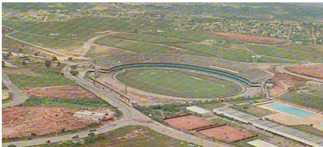
Figura 4 - Etapas iniciais da construção do estádio Fonte: Estádio do Morumbi (s.d.)
