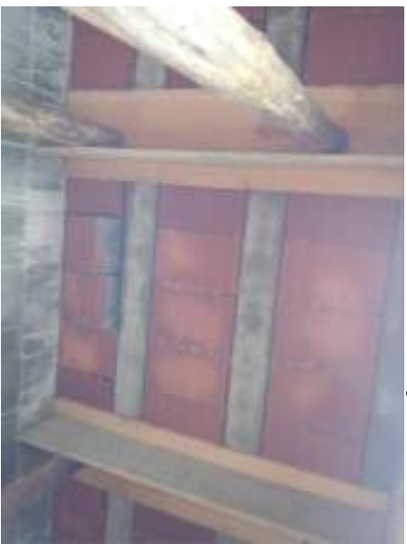
Detalhe do escoramento da Laje do térreo
