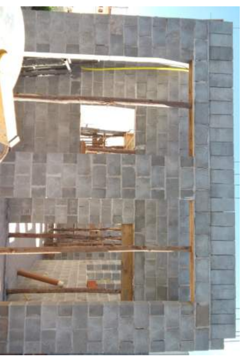
Elevação da parede P01A pelo lado de frente da casa. Alentear com o uso do escoramento.
