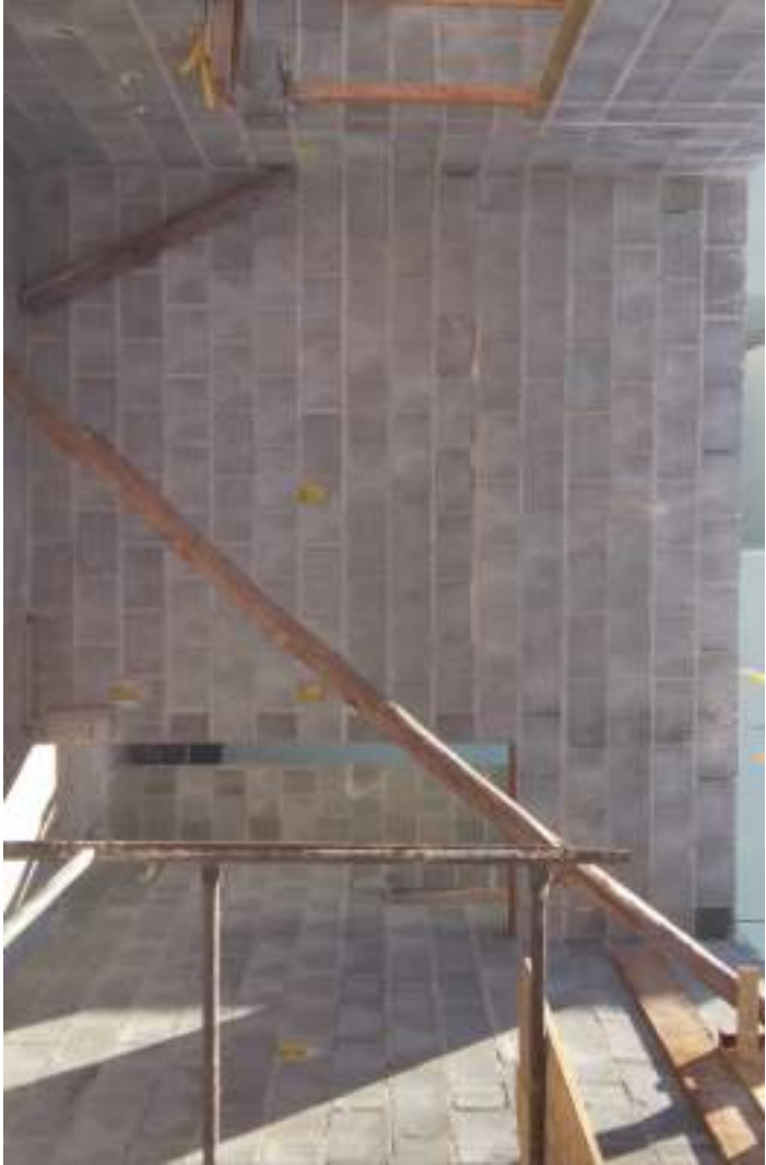
Parede P09 vista pelo lado da cozinha
