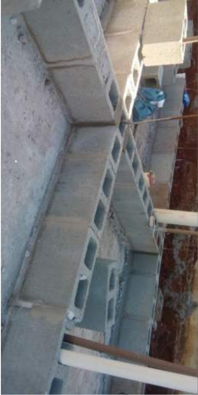
Detalhe do graute e amarração da Parede P09 com a Parede P05 pelo lado da cozinha
