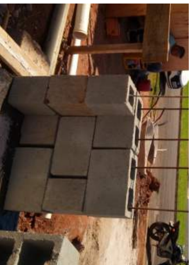
Elevação da parede P01A sob a estaca E32 e Bloco BL20
