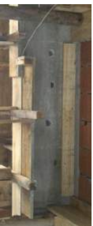
Detalhe dos furos de 5 cm da Viga VL
