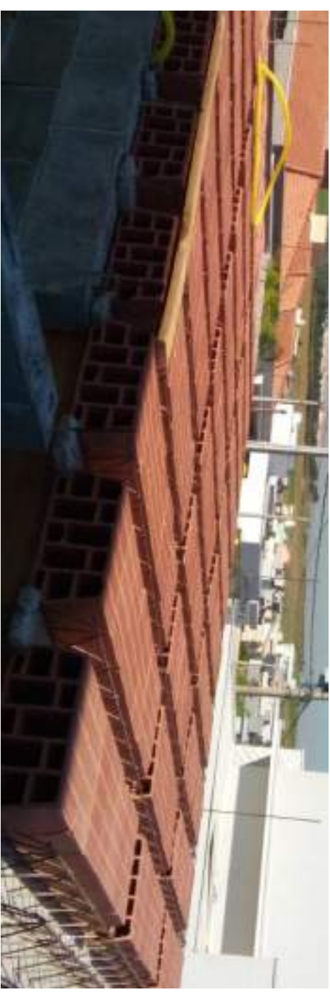
Detalhe da montagem da laje principal: Região da sala, foto tirada na escada
