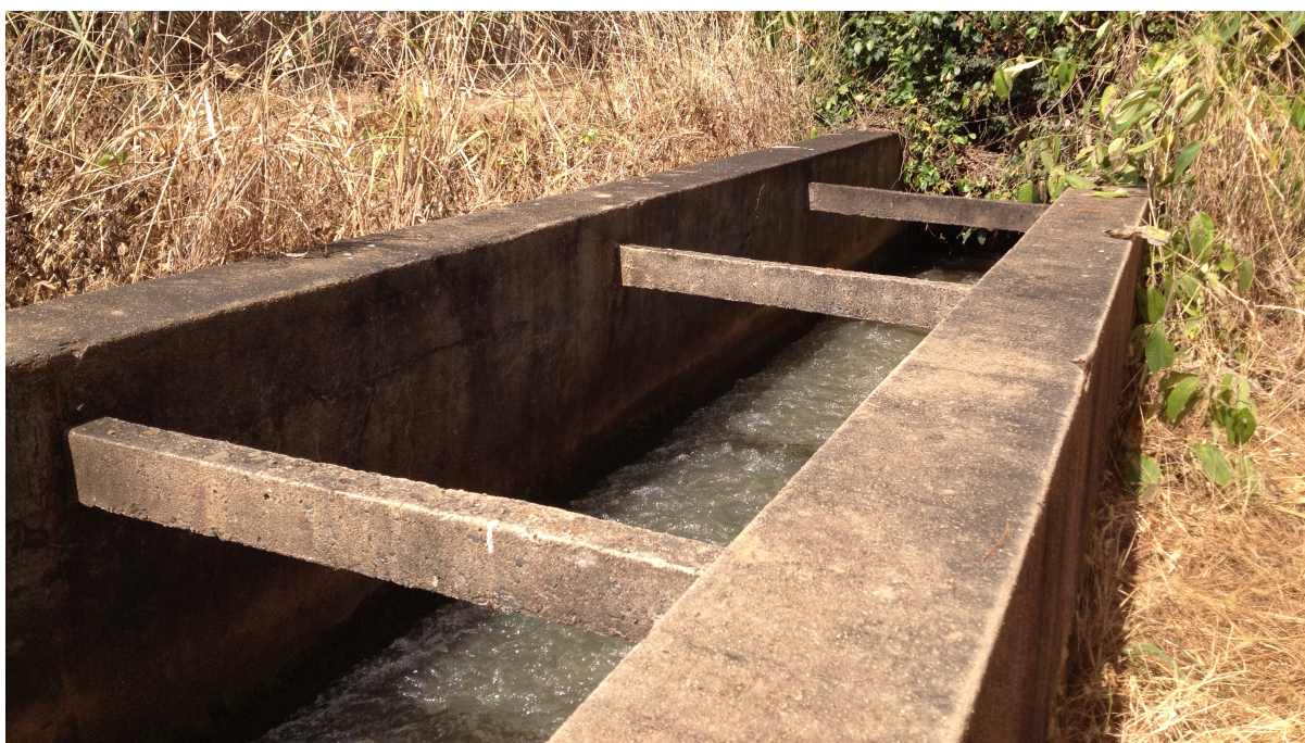
Figura 25 – Direcionamento da água captada para a usina
