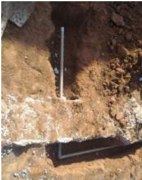
Detalhe da passagem da alimentação de água da torneira de jardim pela viga baldrame
