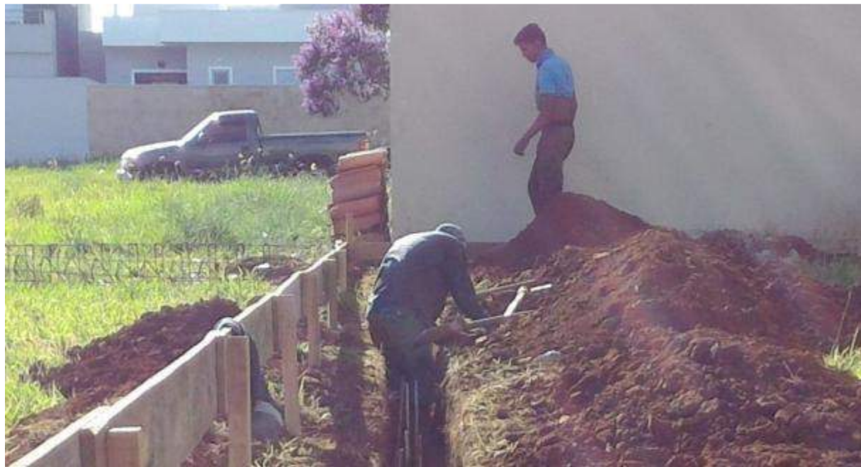
Figura 37 – Escavação das vigas baldrames – 23/02/2017
