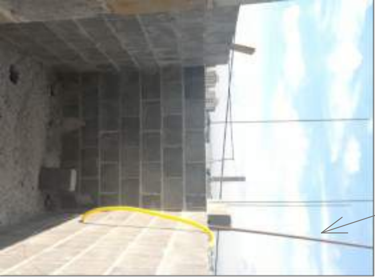
Detalhe da passagem da alimentação pelo banheiro da suite master para continuar a subida
