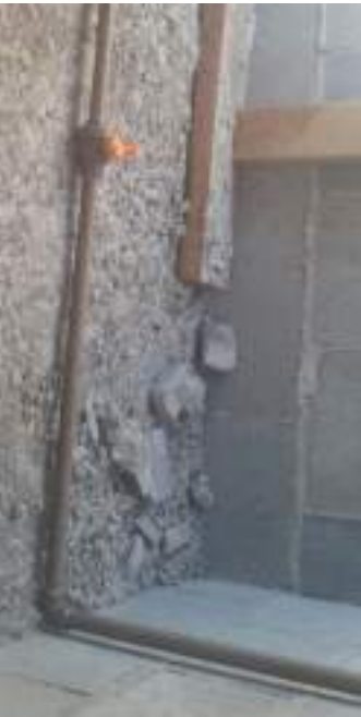
Detalhe da alimentação da caixa de água
