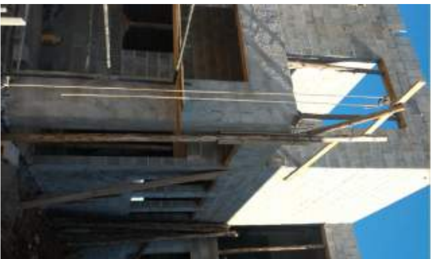
Detalhe da Polia para subida de blocos fixada junto a da Parede P08
