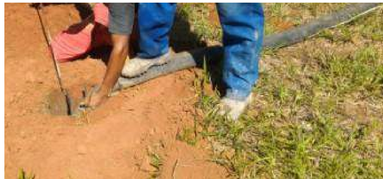
Figura 36 – Concretagem das estacas – 21/02/2017
