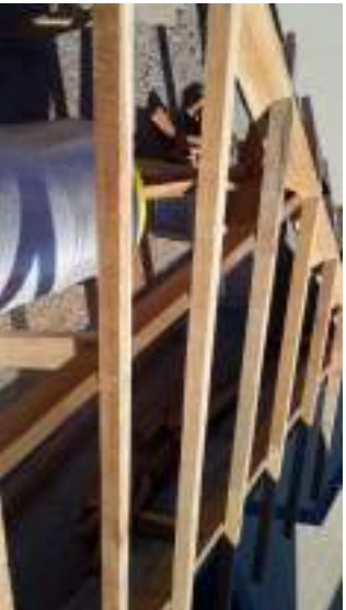
Detalhe dos caibros sobre o Boiler
