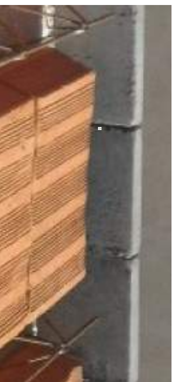
Detalhe da laje na canaleta J
