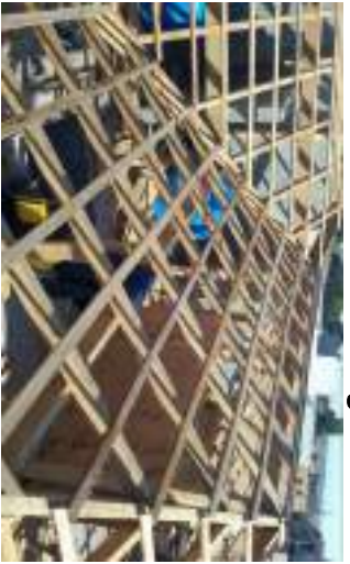
Detalhe da estrutura da Água furtada
