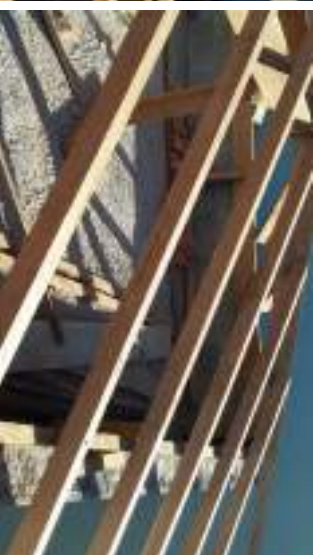
Detalhe do apoio dos caibros
