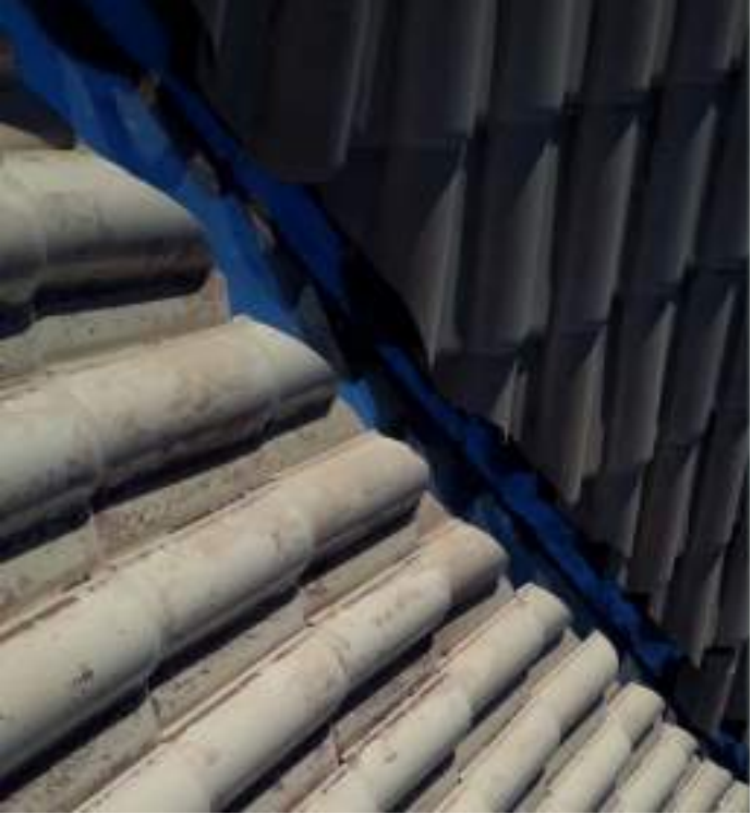
Detalhe do lançamento das telhas cerâmicas
