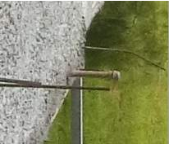
Detalhe da proteção da tubulação de alimentação após a concretagem da viga e do piso. Atentar para usar um tubo luva de proteção
