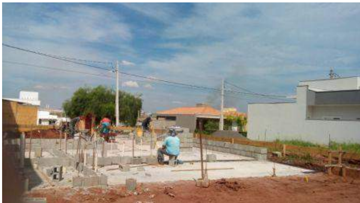
Figura 39 – Execução da primeira fiada – 05/04/2017
