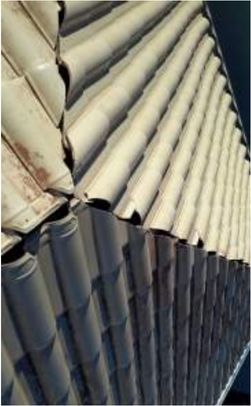
Detalhe do recorte das telhas
