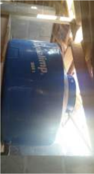
Elevação da caixa de água em 80 cm
