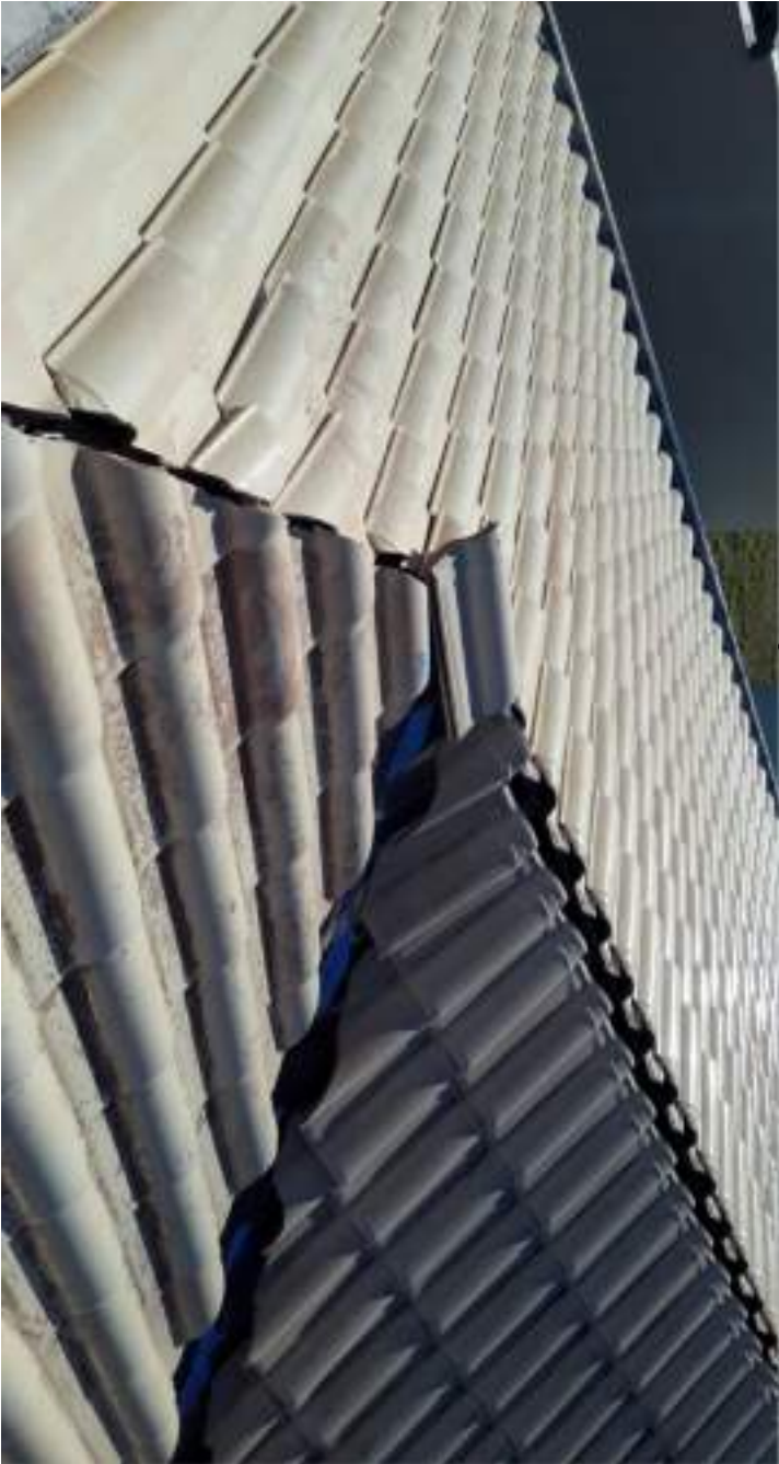
Detalhe do lançamento das telhas cerâmicas
