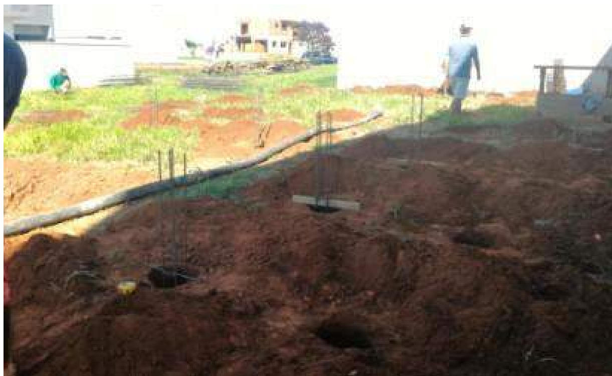
Figura 35 – Estacas preparadas para concretagem – 21/02/2017
