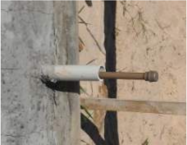
Detalhe da proteção da tubulação de alimentação após a concretagem da viga e do piso. Atentar para usar um tubo luva de proteção
