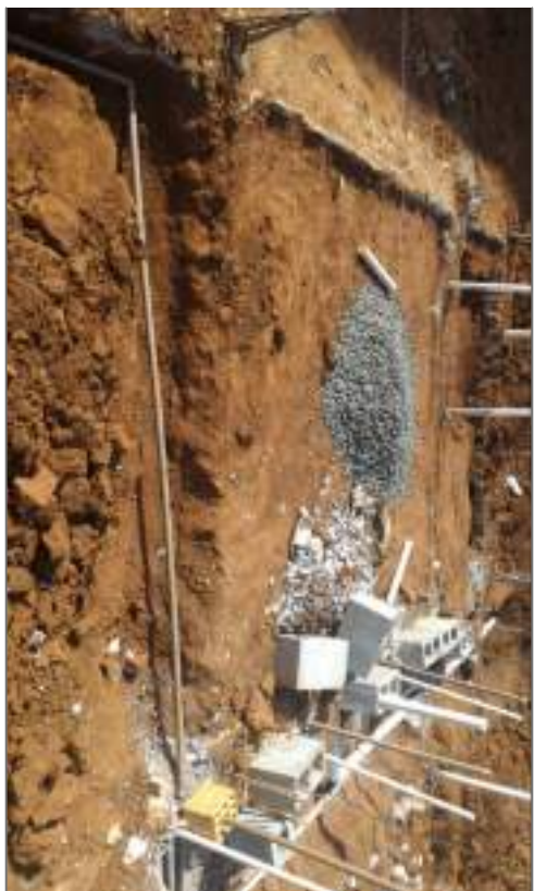
Detalhe da passagem da alimentação de água da torneira de jardim pela viga baldrame
