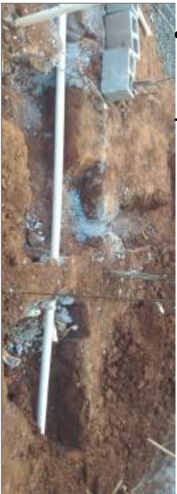
Executar as tubulações hidrosanitárias antes da concretagem da viga baldrame pra evitar retrabalhos
