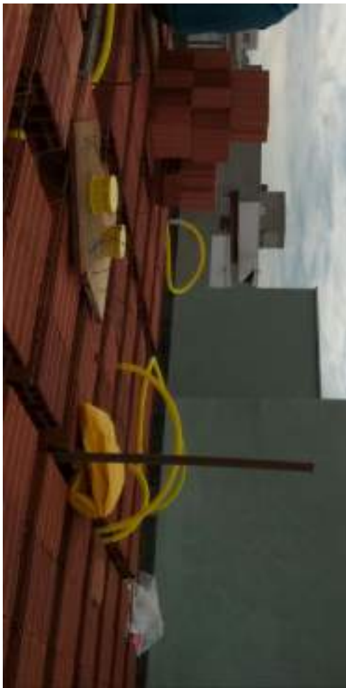
Na montagem da laje atentar para os pontos de passagem de instalações elétricas e hidráulicas
