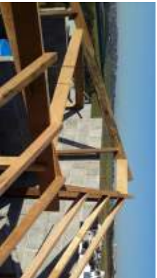
Detalhe da estrutura da água furtada
