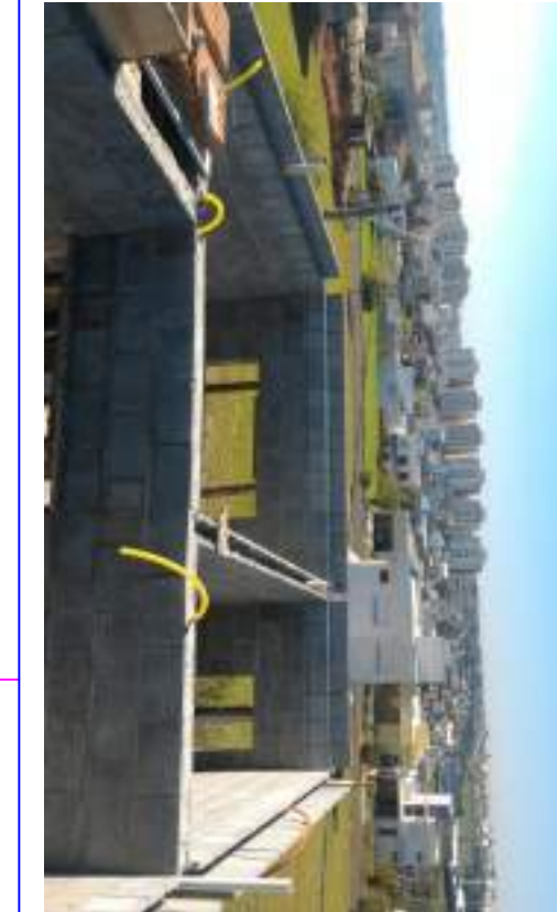
Elevação da alvenaria da suíte master antes da montagem da laje
