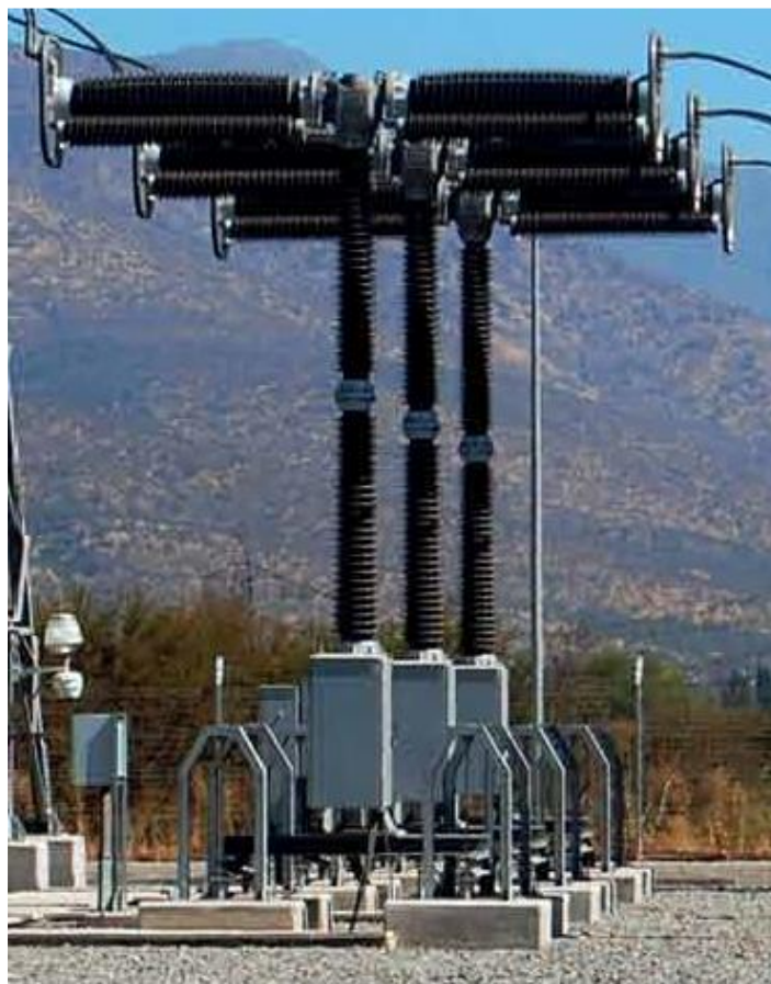
FIGURA 11 – DISJUNTOR ISOLADO À ÓLEO INSTALADO EM CAMPO
