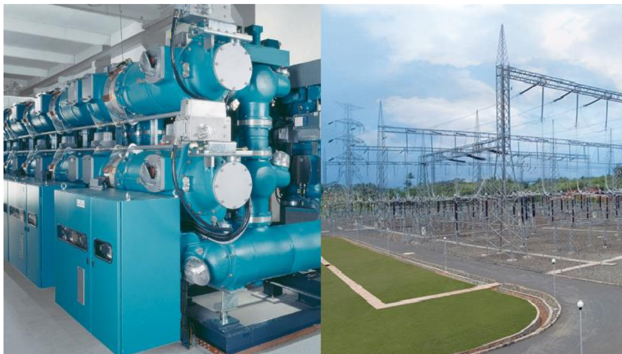
FIGURA 9 - SUBESTAÇÃO ISOLADA À GÁS (À ESQUERDA) E SUBESTAÇÃO ISOLADA À AR (À DIREITA)
