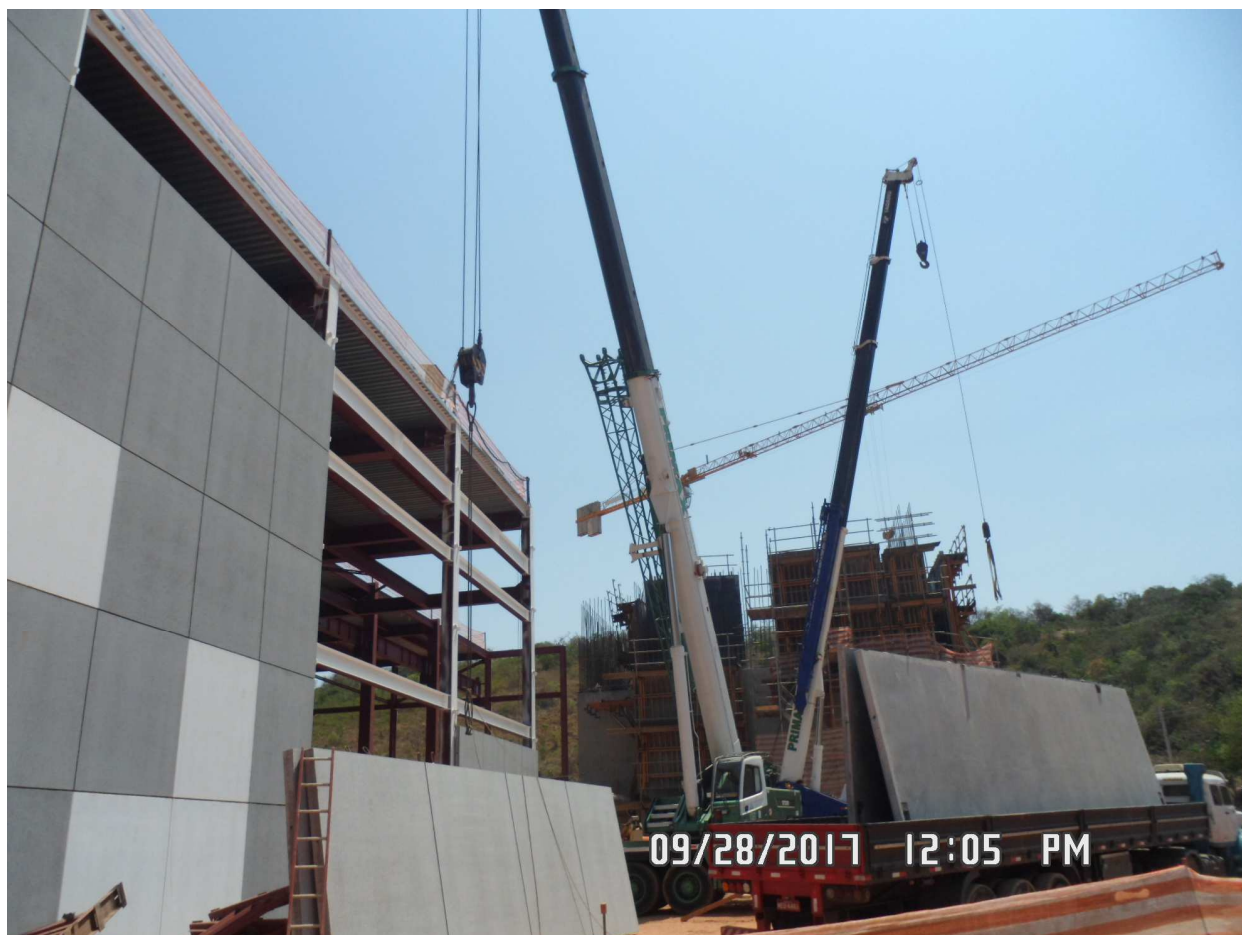
Foto 1 - Elemento pré-moldado de concreto apoiado sob solo estável e em posição vertical para ancoragem dos ganchos de travamento para o içamento
