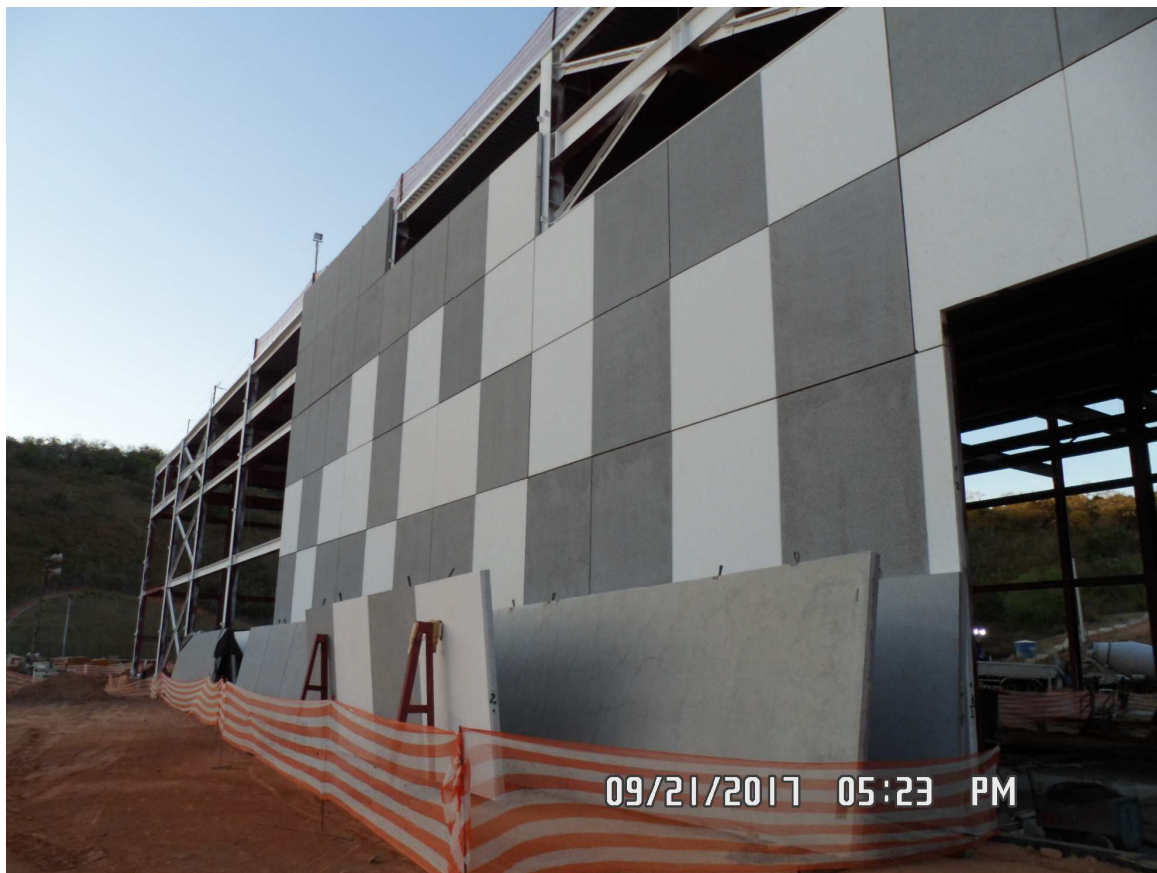
Foto 2 - Elemento pré-moldado de concreto apoiado sob solo estável e em posição vertical para ancoragem dos ganchos de travamento para o içamento
