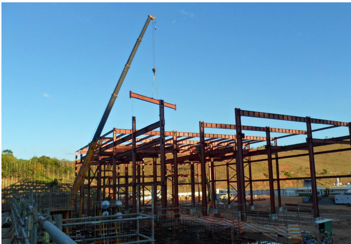
Foto 4 - Riscos materiais no travamento adequado da peça a ser içada.
