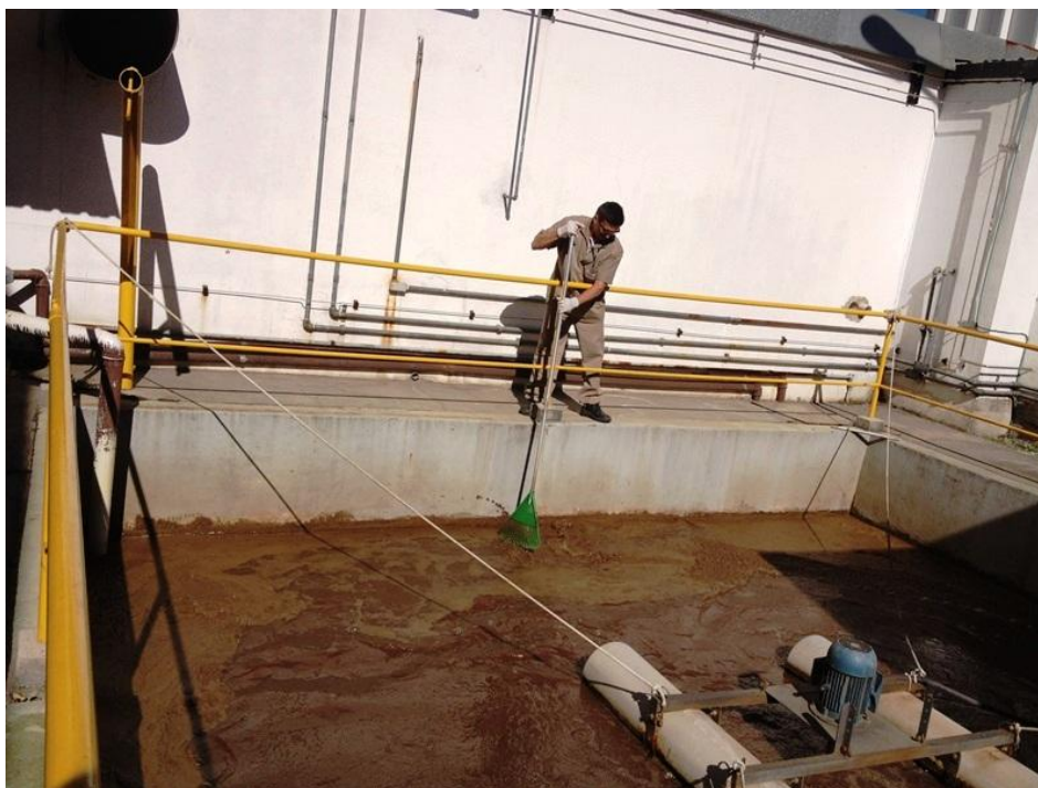
Figura 41 - Ausência de respirador
