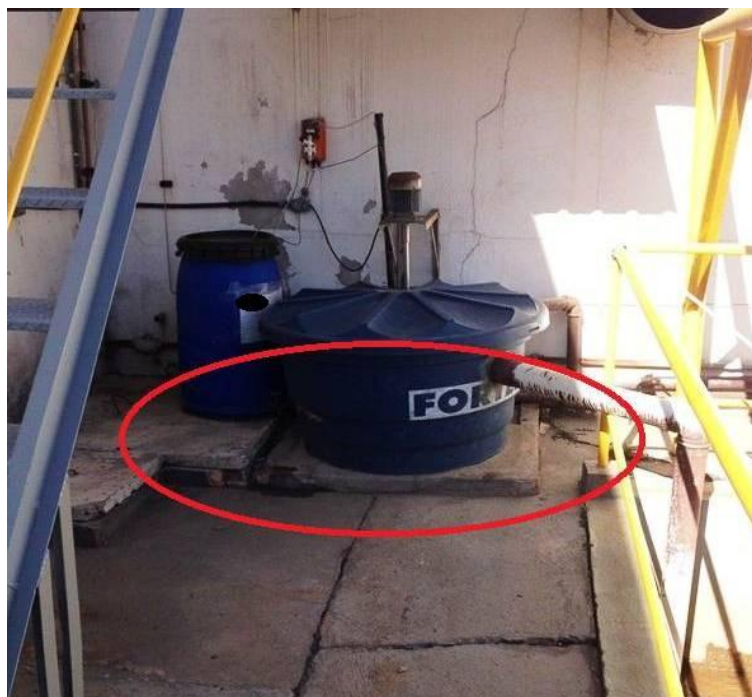
Figura 33 - Ausência de dique de contenção
