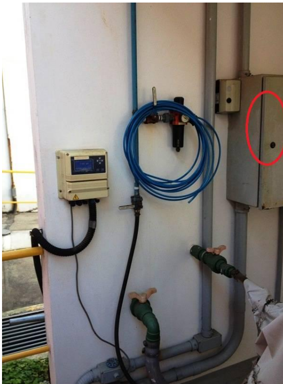
Figura 18 - Falta identificação do quadro elétrico
