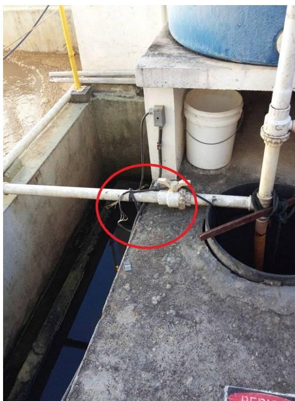
Figura 22 - Fio elétrico desencapado
