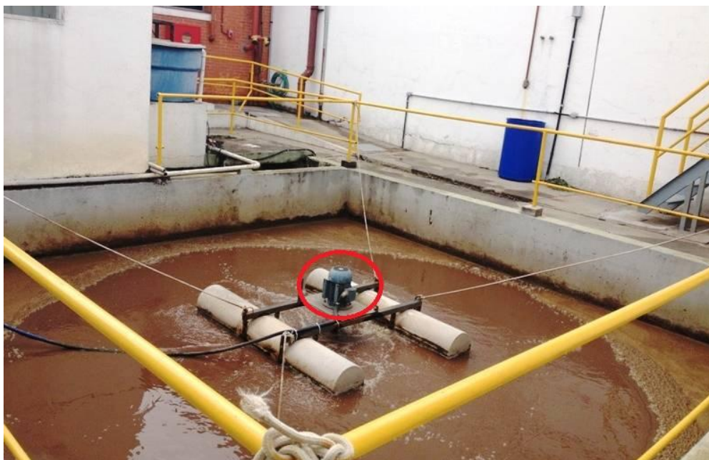
Figura 12 - Motor sem proteção no tanque de aeração
