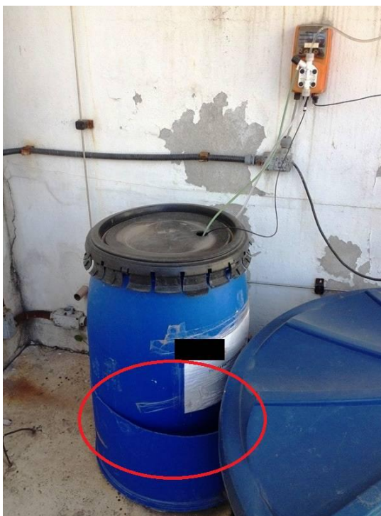
Figura 31 - Tambor com Hidróxido de Sódio danificado
