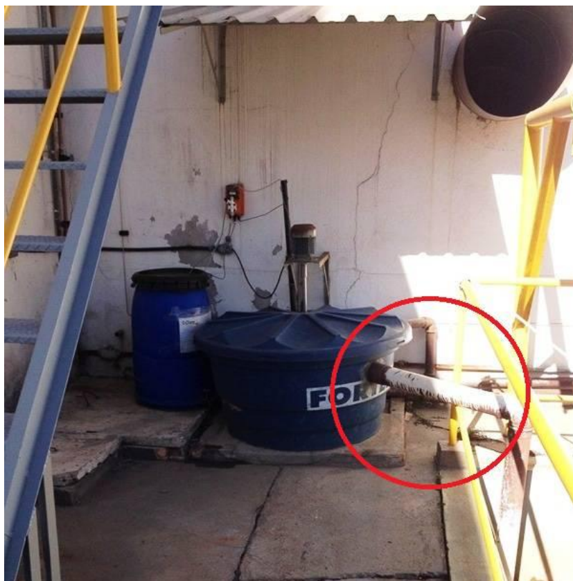
Figura 26 - Dificuldade de passagem devido tubulação
