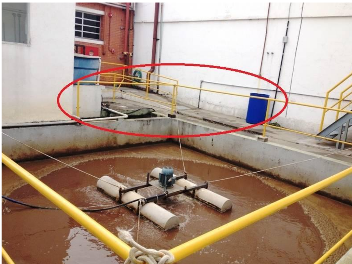
Figura 11 - Falta das travessas no guarda corpo e controle de entrada
