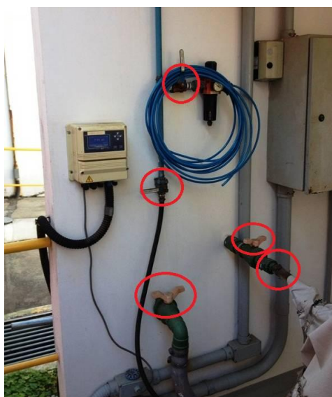
Figura 16 - Conexões enferrujadas e torneira plástica
