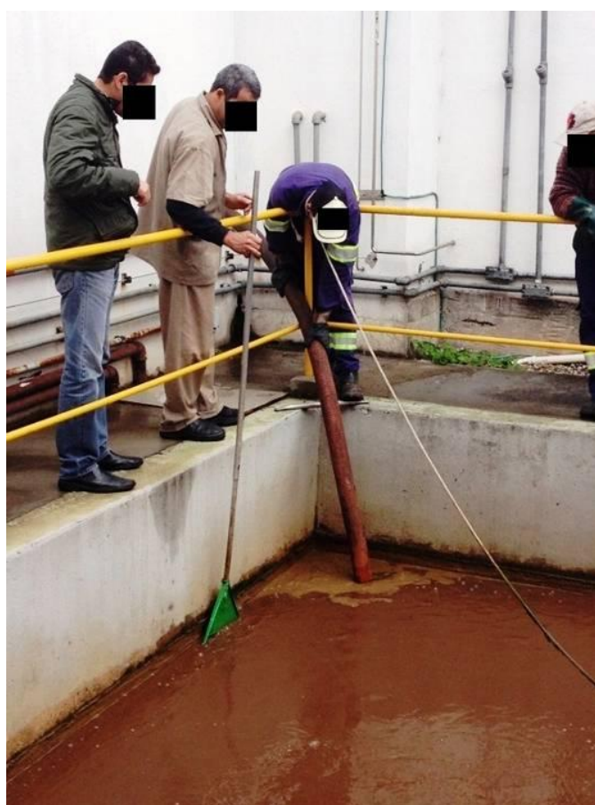
Figura 45 - Ausência EPI e risco de queda
