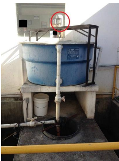
Figura 24 - Motor de retorno sem proteção
