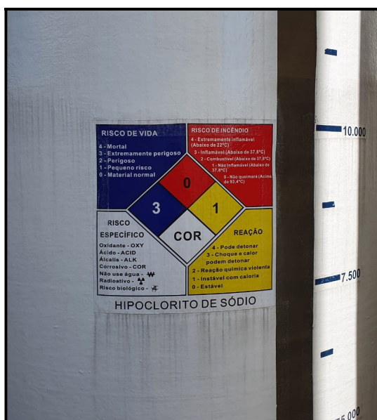
Figura 7 - Silos de Hipoclorito de Sódio
