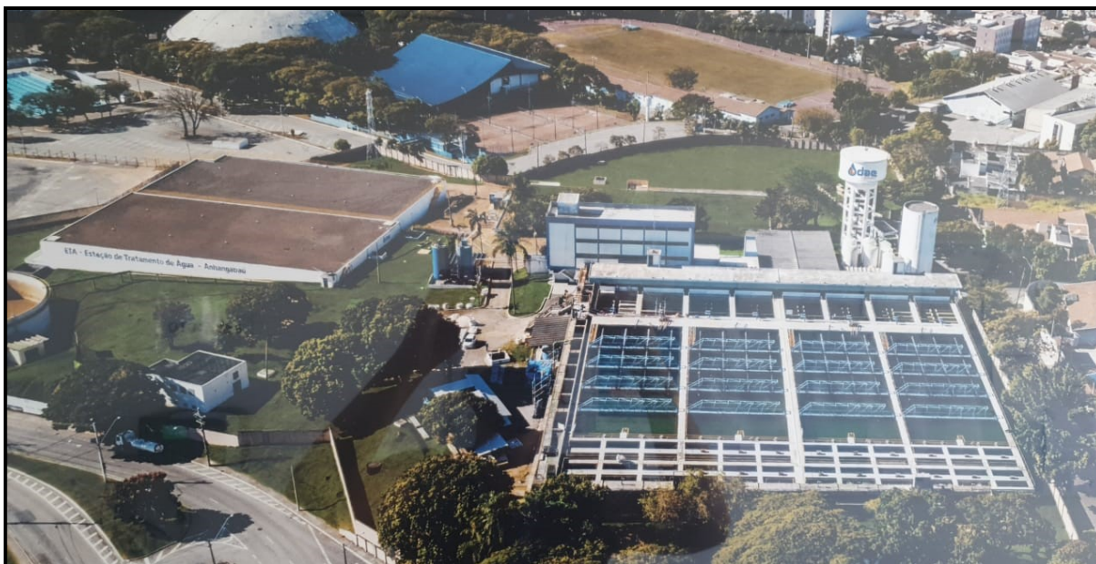
Figura 5 - Imagem Aérea da Estação de Tratamento de Água
