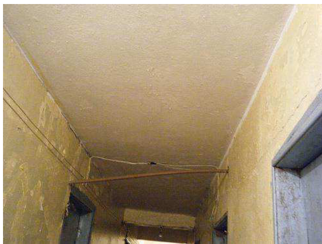
Figura 30: encanamentos que levam a águas aos pontos individuais. Foto tirada pelo grupo.
