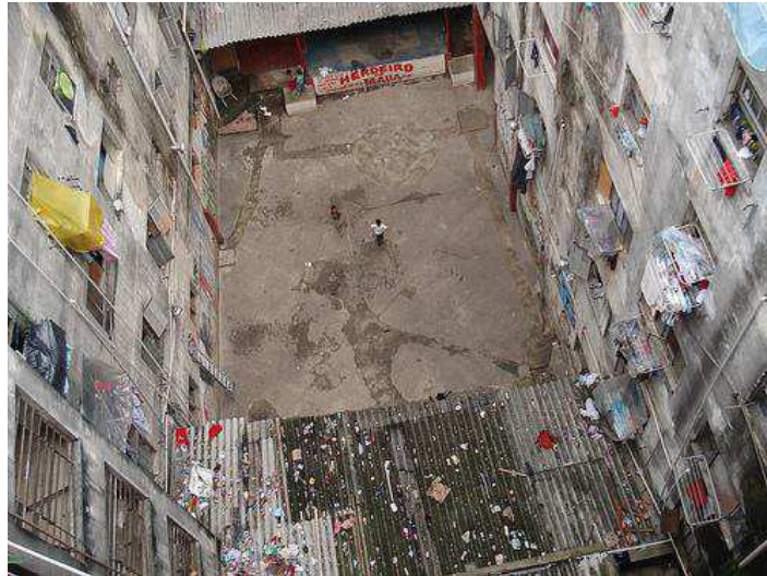
Figura 44: pátio interno visto da cobertura. Foto tirada pelo grupo.
