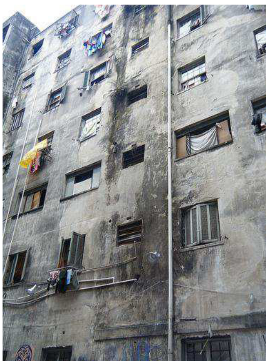
Figura 31: visão das paredes do pátio interno, por onde passam os encanamentos dos esgotos. Foto tirada pelo grupo.
