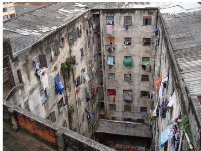
Figura 33: vista do telhado do prédio
