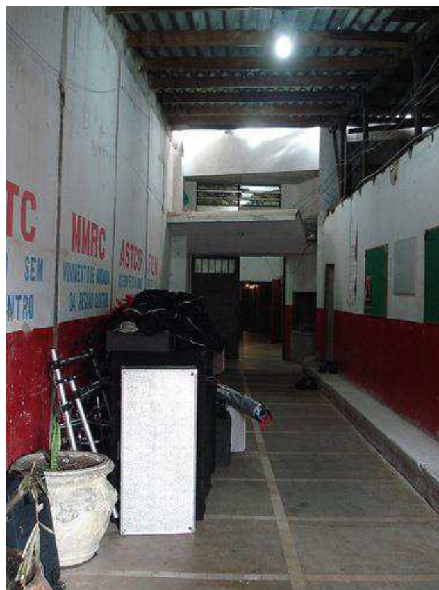
Figura 17: corredor que dá acesso ao térreo. Foto tirada pelo grupo.
