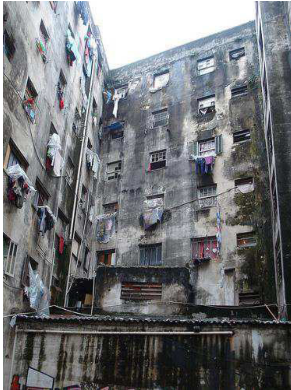
Figura 19: vista do prédio a partir do pátio interno. Foto tirada pelo grupo.
