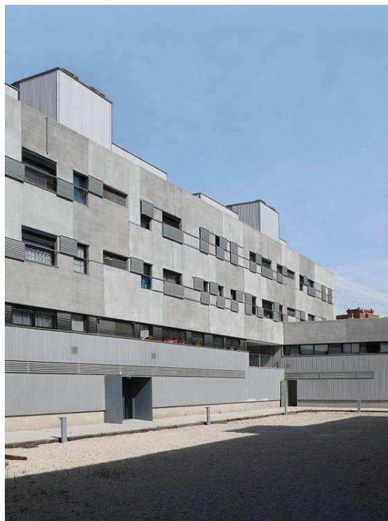
Figura 86: Vista Pátio Interno e Fachada do edifício – Aranguren + Gallego Arquitectos. Carabanchel Dwelling, Madrid. Fonte: arangurengallegos.com
