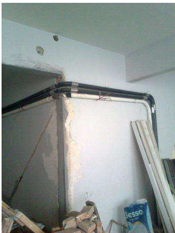
Figura 57: detalhe do sistema elétrico no edifício da Xavier. Foto tirada pelo grupo.
