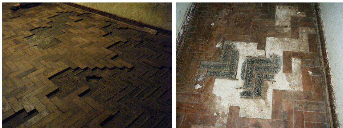
Figura 38: tacos dos corredores. Foto tirada pelo grupo.
