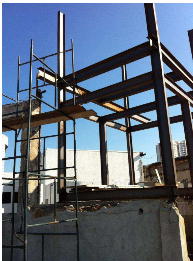
Figura 99: Montagem de peças metálicas na cobertura através de andaimes e guindaste - detalhes de obra visitada pelo grupo. Fonte: elaboração própria.
