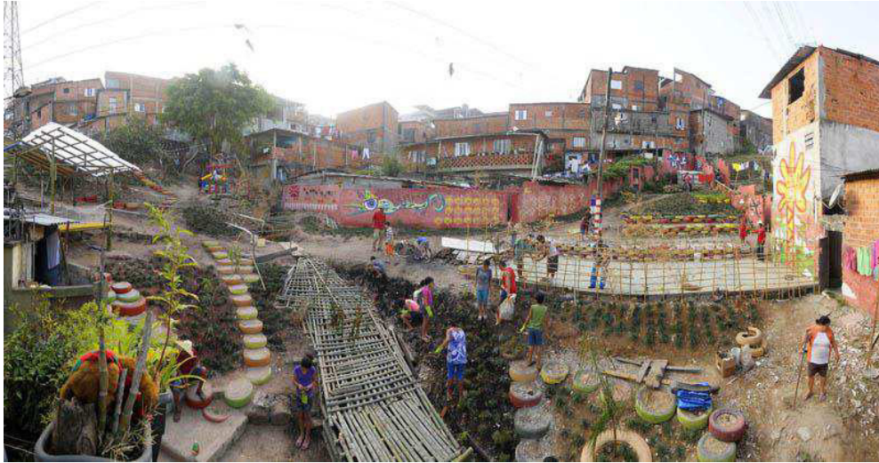
Figura 80: Parque Para Brincar e Pensar-Obra Finalizada. Autor: Projeto Filé. Fonte: parqueparabrincarepensar.blogspot.com.br
