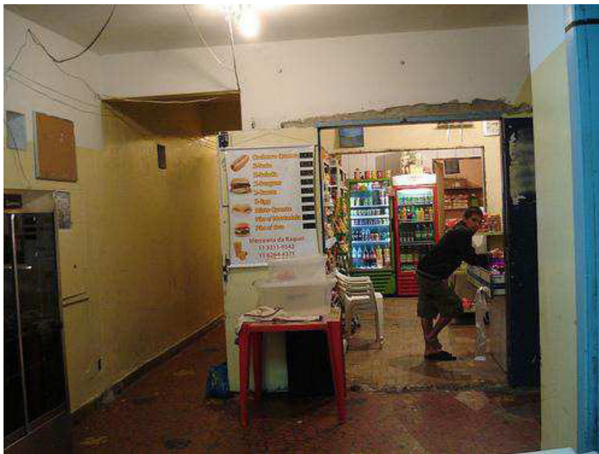
Figura 18: estabelecimento comercial no primeiro andar. Foto tirada pelo grupo.
