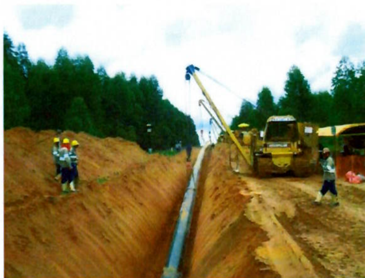
Figura 5.3.1 - Vista do lançamento de um duto de 24" na vala
