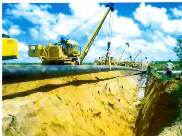
Figura 5.3.2 - Vista do lançamento de um duto de 24" na vala
