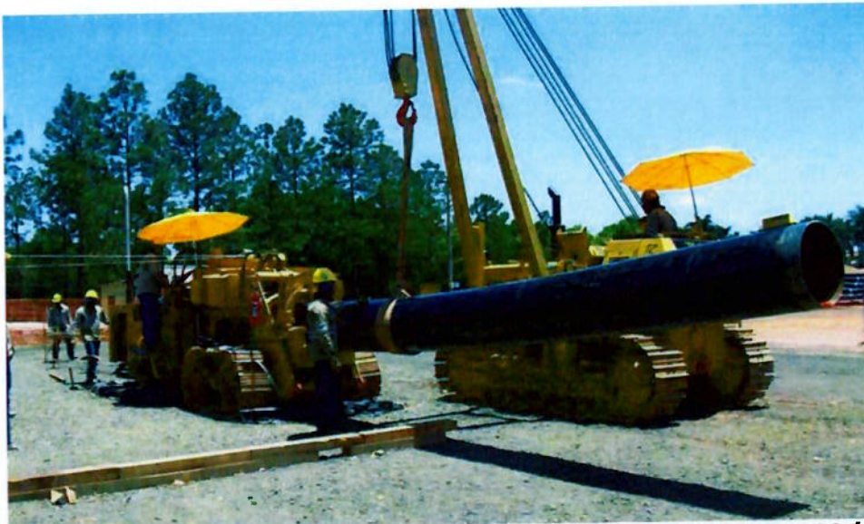
Figura 5.2.1 B - Vista de máquina de curvamento a frio com comando hidráulico.
