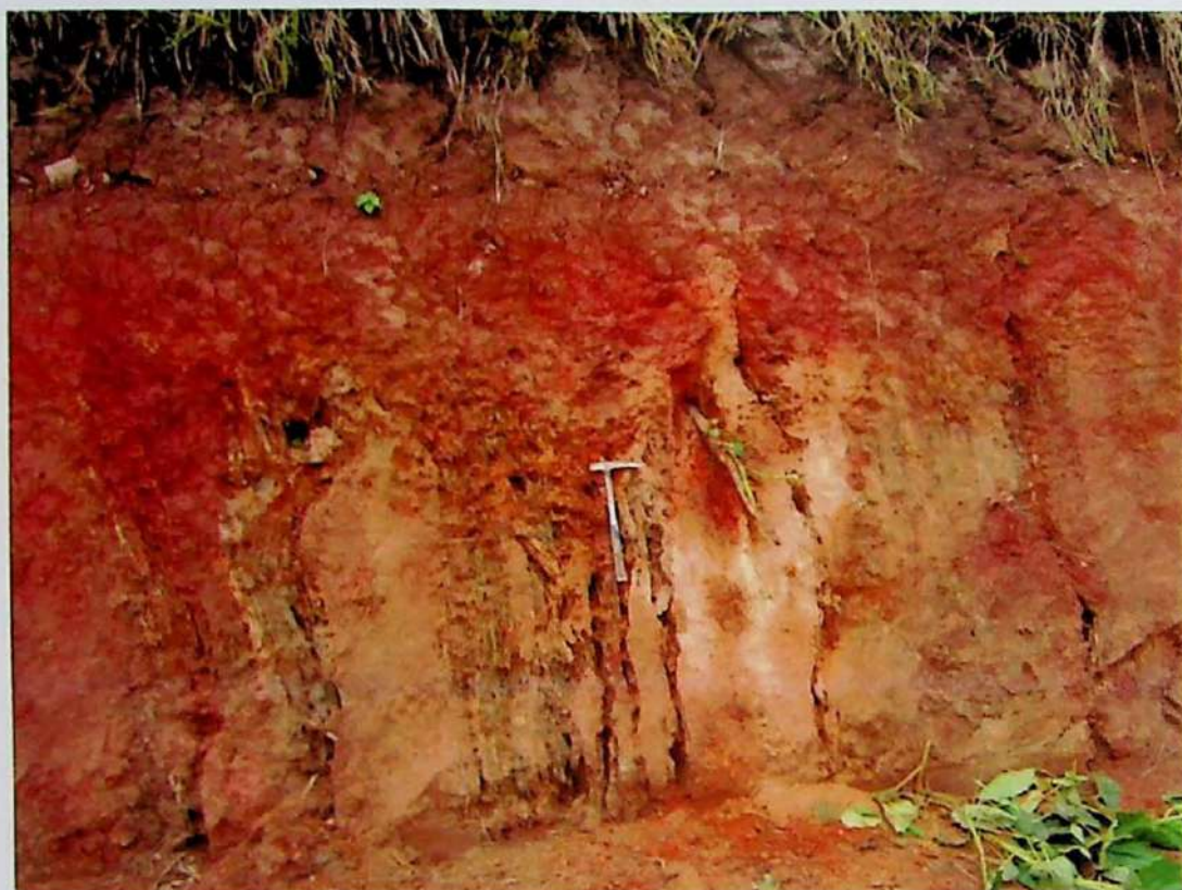
Foto 9 – Feições de erosão linear em barranco de estrada vicinal (Ponto TF-12-23).
