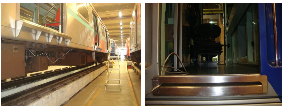
Figura 13 – Detalhes da instalação do cabeamento junto ao trem
