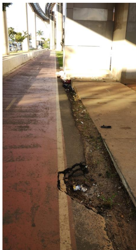
Foto 11 - Ciclovia Vila Prudente: erosão nas bordas da ciclovia.
