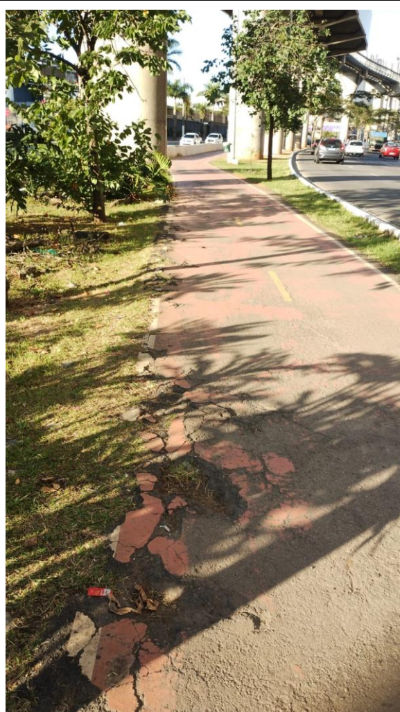
Foto 12 - Ciclovía Vila Prudente: buracos e rachaduras no pavimento da ciclovía.
