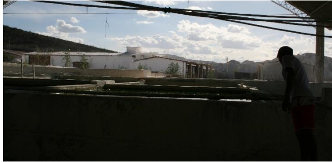
Figura 14 - Tanques em alvenaria e garimpeiro. Junco do Seridó - PB
