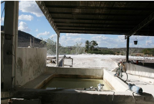
Figura 13 - Tanque em alvenaria para filtragem de material. Junco do Seridó - PB
