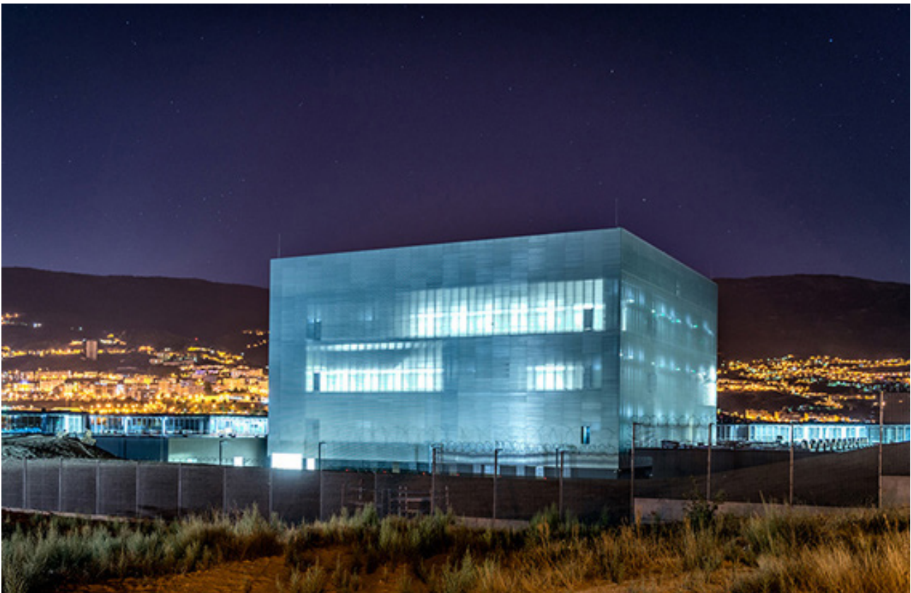
figura 34: Data center PT, Portugal, de noite
