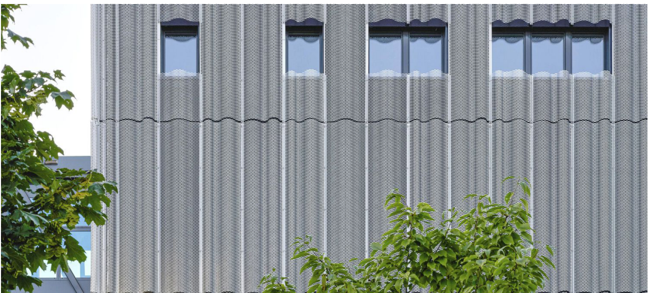
figura 32: ZUR3 Data Center, Suíça, aproximação da chapa metálica da fachada
