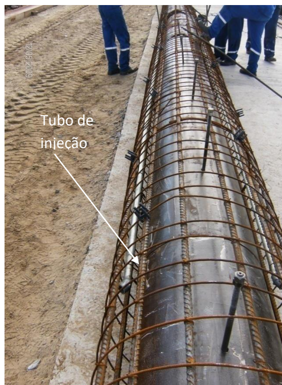
Figura 5-7: Posicionamento dos tubos de injeção antes da concretagem da estaca
