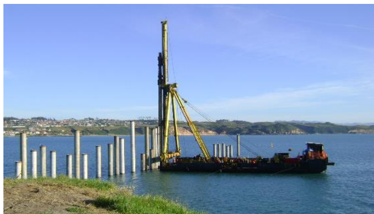
Figura 3-6 - Plataforma flutuante com bate-estaca
