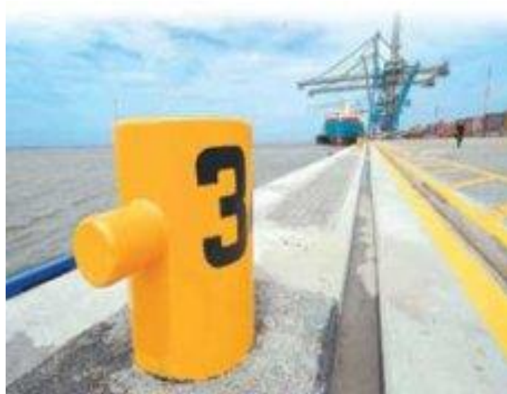
Figura 2-7 - Detalhe de um cabeço de amarração
