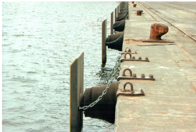
Figura 2-6 - Detalhe das defensas do cais
