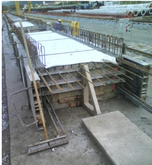
Figura 3-13 - Laje \pi no berço.
