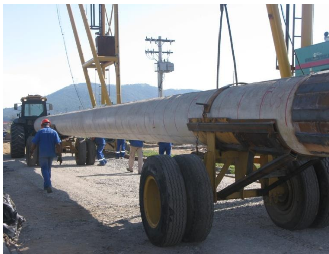
Figura 3-8 - Dolly transportando uma estaca
