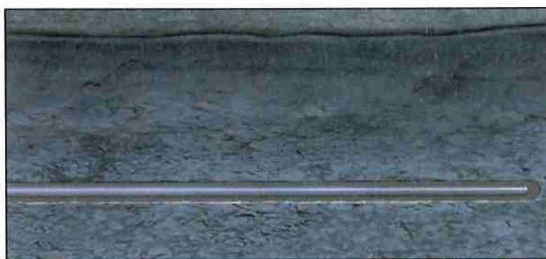
Figura 16: Inserção do revestimento em aço [5]
