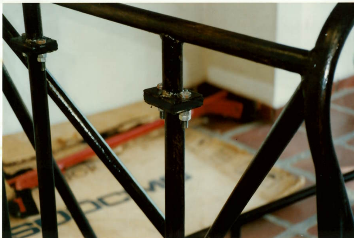
Foto 5 - Detalhe da Fixação do Suporte do Motor à Estrutura
