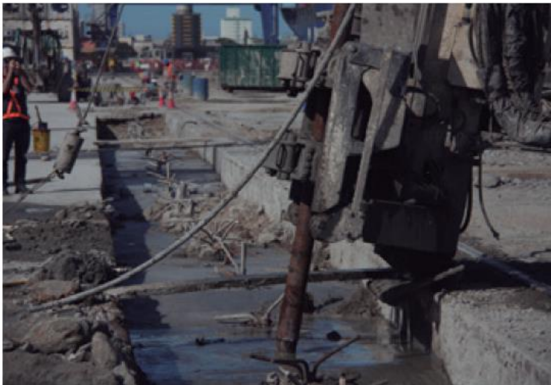
Figura 21 - Colunas de jet-grouting armado sendo realizadas no retroporto em Navegantes.
