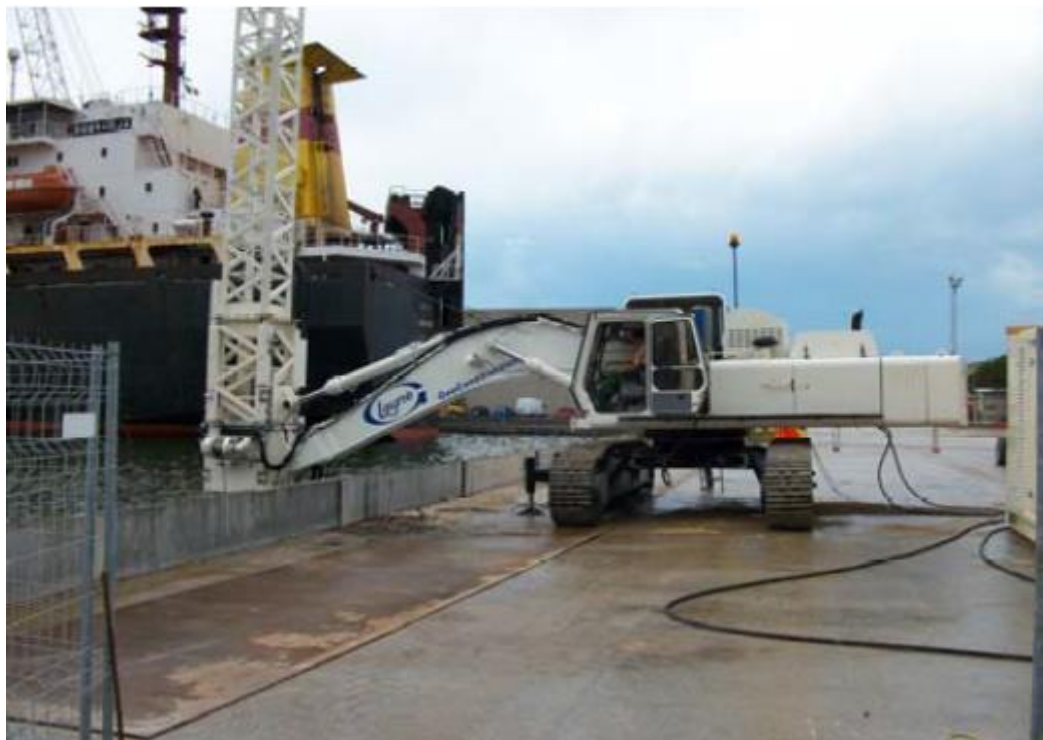
Figura 29 - Realização dos tirantes submersos de jet-grouting armado de prova.
