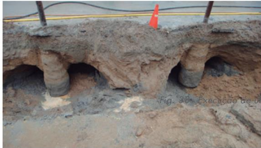
Figura 22 – Estacas testes de jet-grouting armado no Porto de Navegantes.
