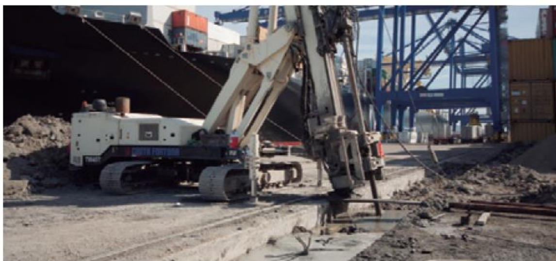
Figura 20 - Colunas de jet-grouting armado sendo realizadas no retroporto em Navegantes.
