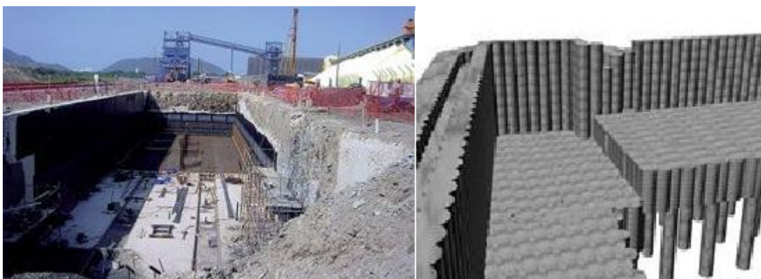
Figura 13 - Jet-grouting armado como contenção lateral e de fundo em Guarujá (SP).
