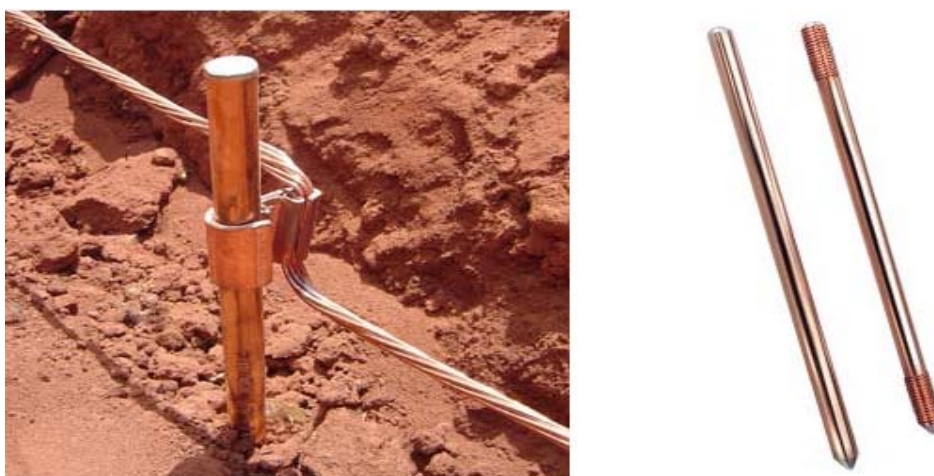
Figura 1 - A esquerda uma haste de aterramento cravada no chão (com um conector cunha já instalado) e a direita dois tipos de hastes. (Fonte: adaptado de “ www.intelli.com.br ”)
