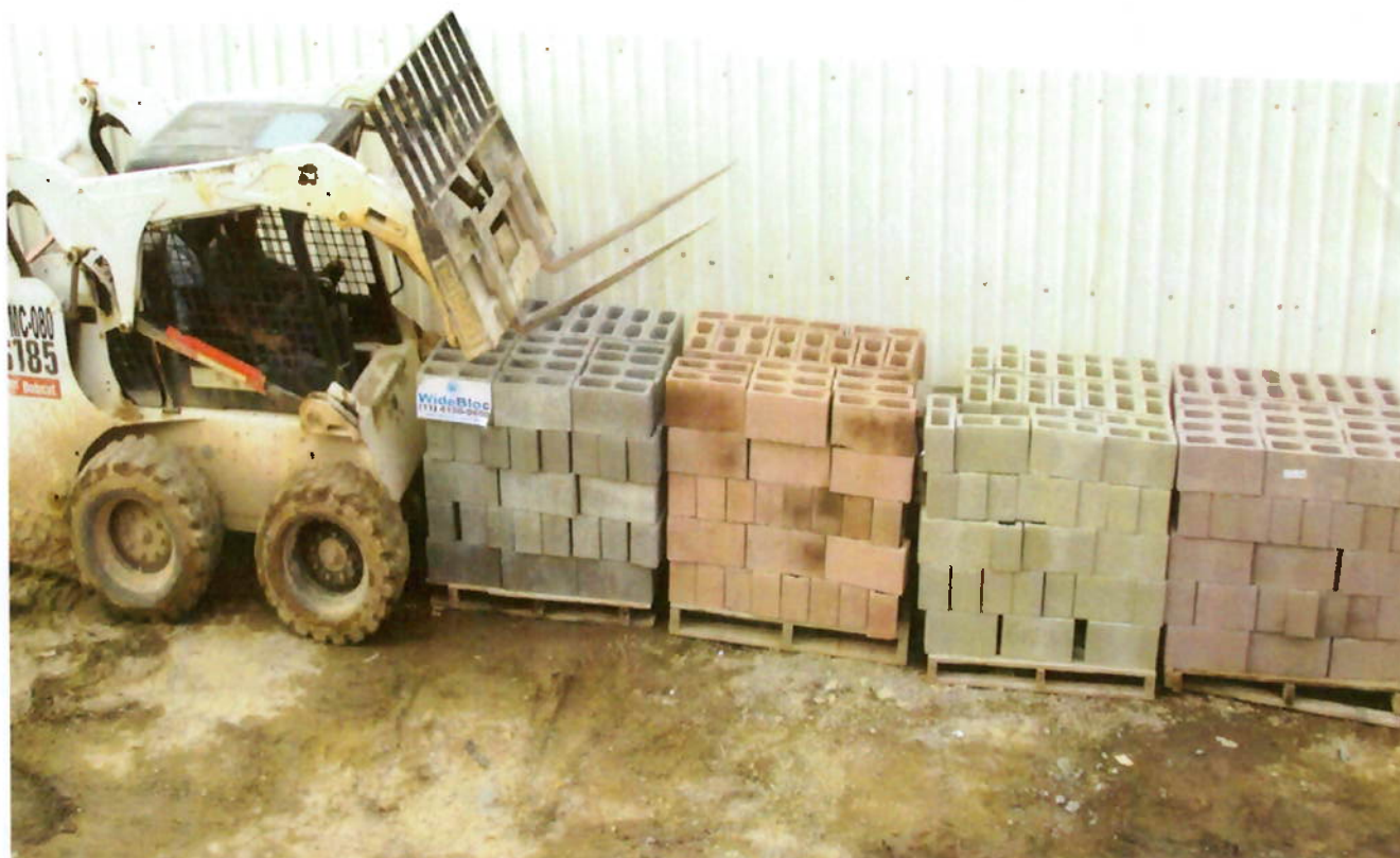
Figura 83 - Paletes de blocos de cada resistencia em frente à obra e a Bob Cat com "garfo" (fonte: arquivo Schahin)
