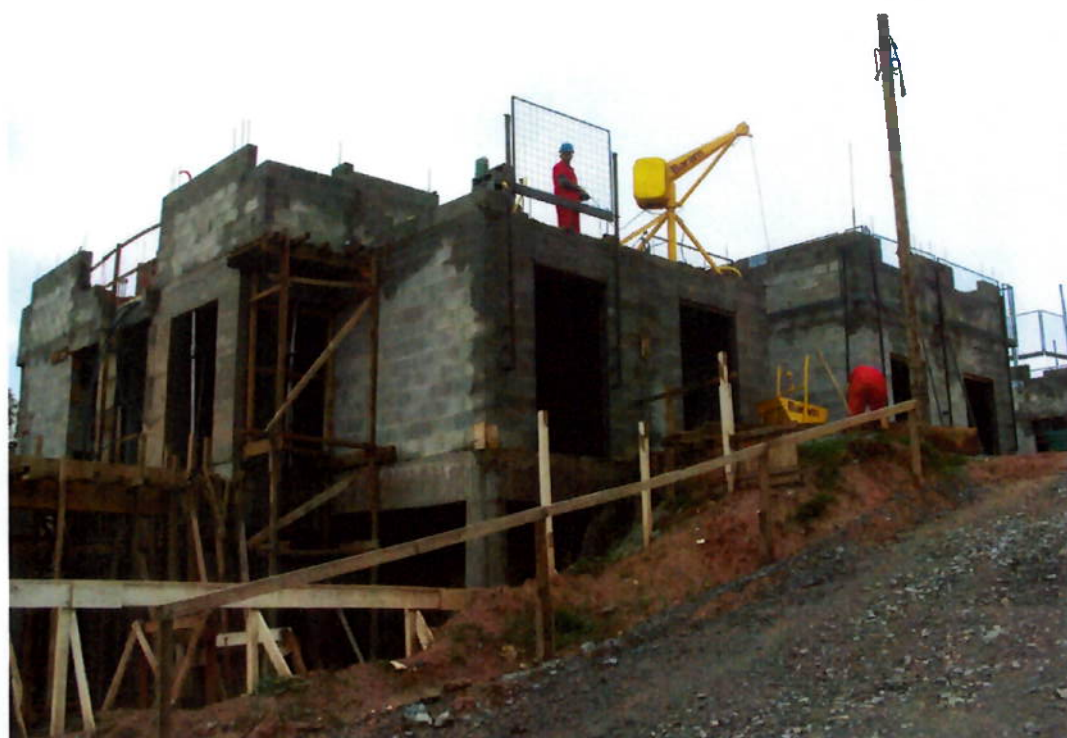
Figura 48 - Operário aguardando carregamento de carrinho de graute para ser içado pela mini-grua (fonte: Arquivo Schahin)
