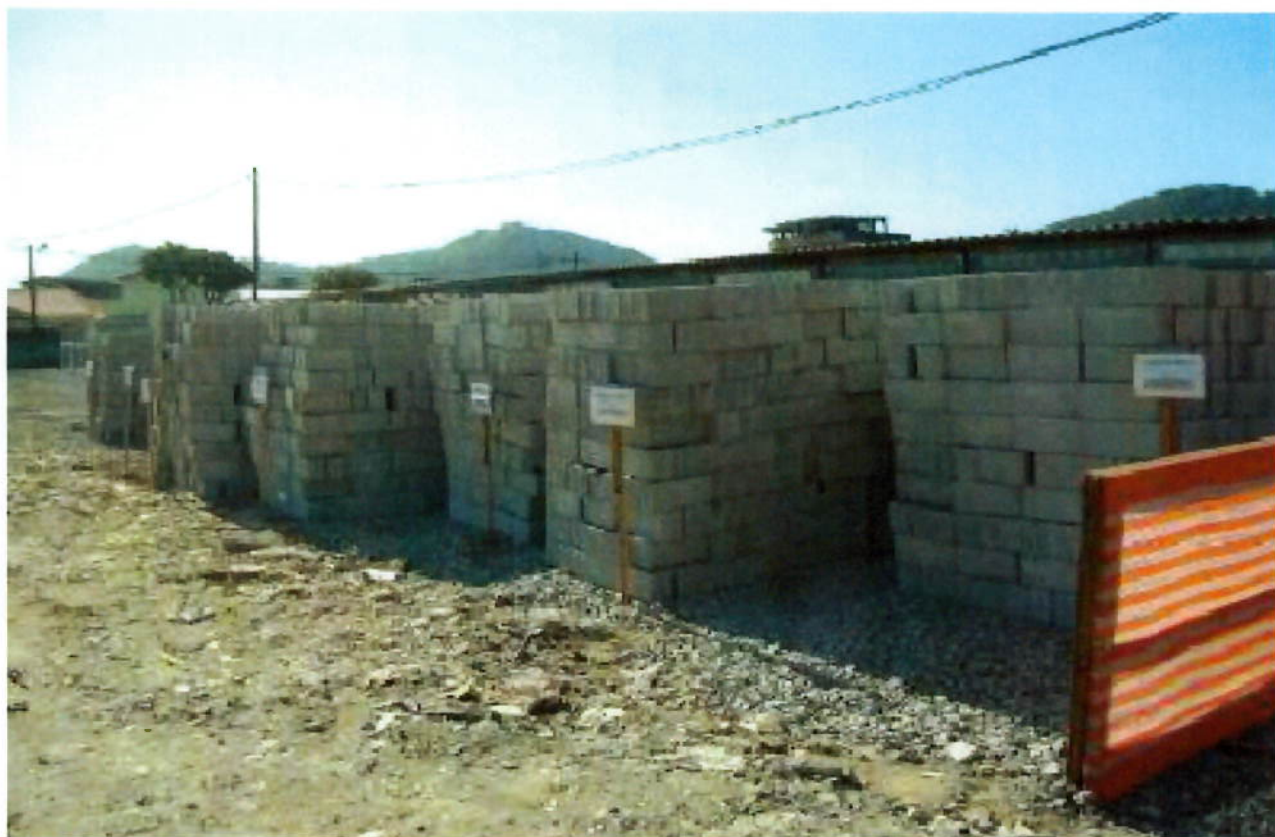
Figura 66 - Foto de estoque de bloco em obra – identificação com plaquetas (outubro / 2010- fonte: Arquivo Schahin)
