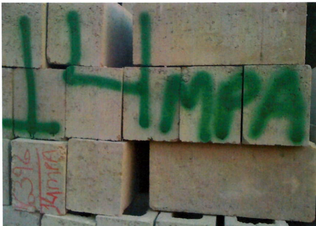
Figura 61 - Foto de estoque de bloco em obra – identificação com tinta “spray” utilizando critério de cores para a tinta conforme a resistência específica dos blocos (fonte: Eng. José Carlos de S. Leme Jr.)
