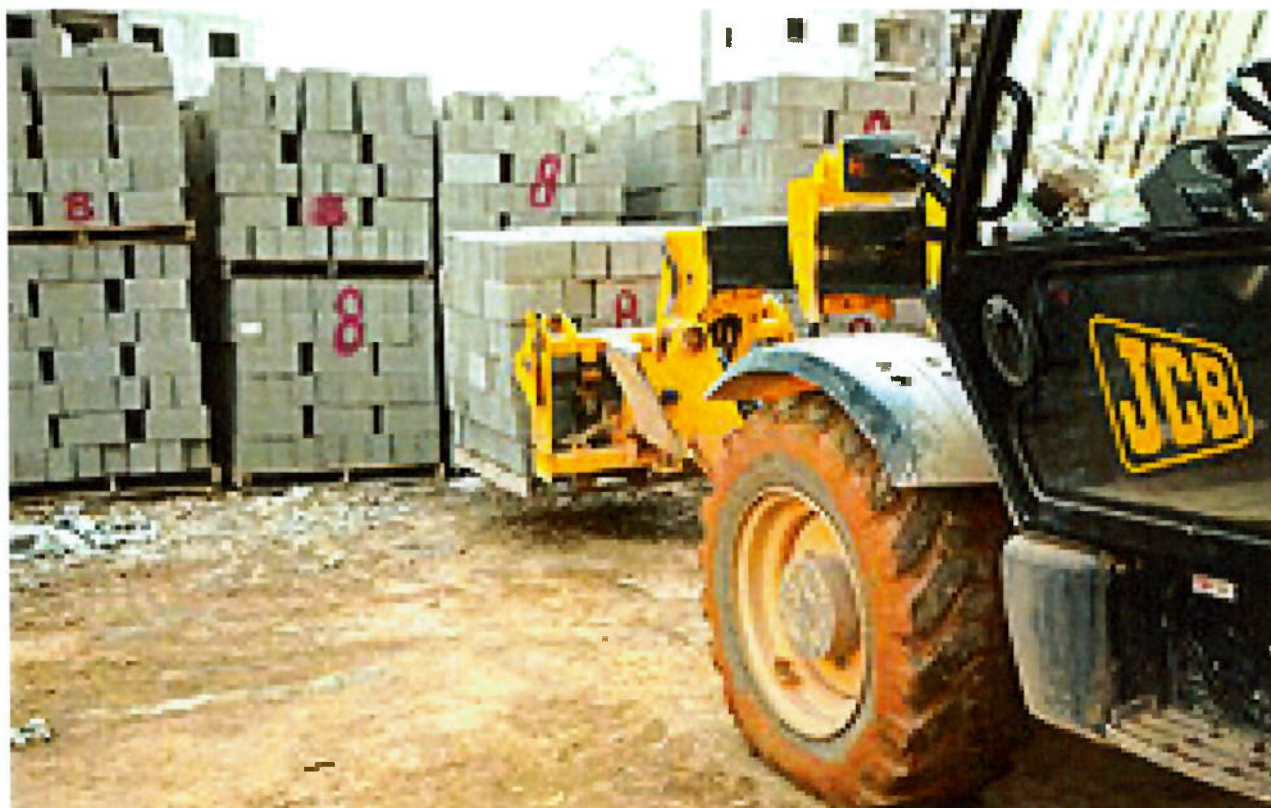
Figura 64 - Movimentação dos pallet's previamente identificados para estoque na obra através de mini-carregadeira (fonte: Revista Técnica – outubro / 2010)
