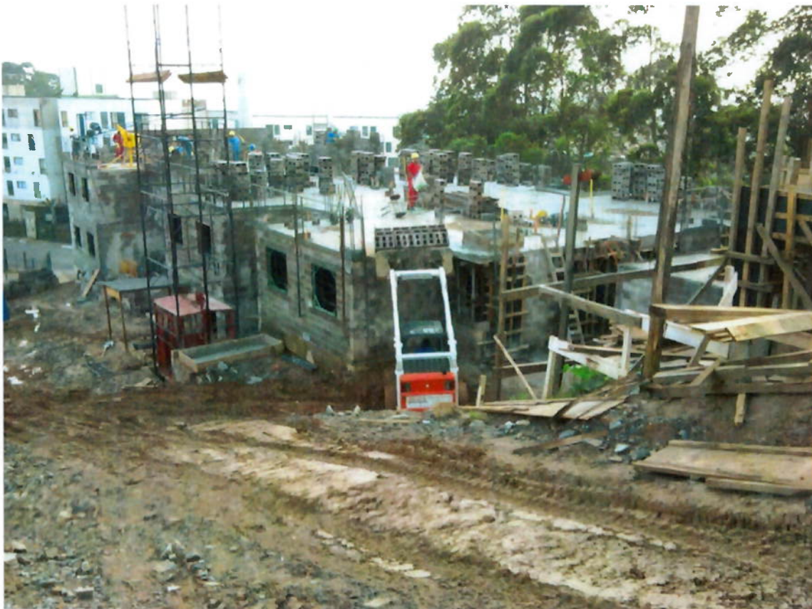
Figura 40 - Bob Cat abastecendo com blocos um dos pavimentos do prédio 05 (fonte: Arquivo Schahin)
