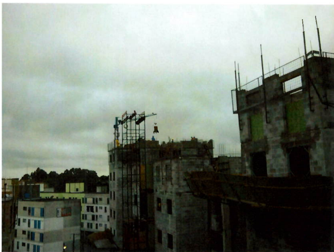
Figura 50 - Içamento pela mini-grua de carrinho de blocos (fonte: Arquivo Schahin)
