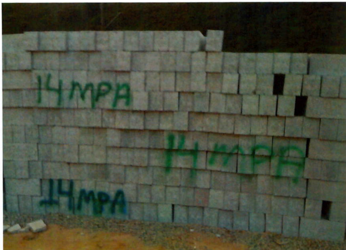
Figura 60 - Foto de estoque de bloco em obra – identificação com tinta “spray” utilizando critério de cores para a tinta conforme a resistência específica dos blocos (fonte: Eng. José Carlos de S. Leme Jr.)
