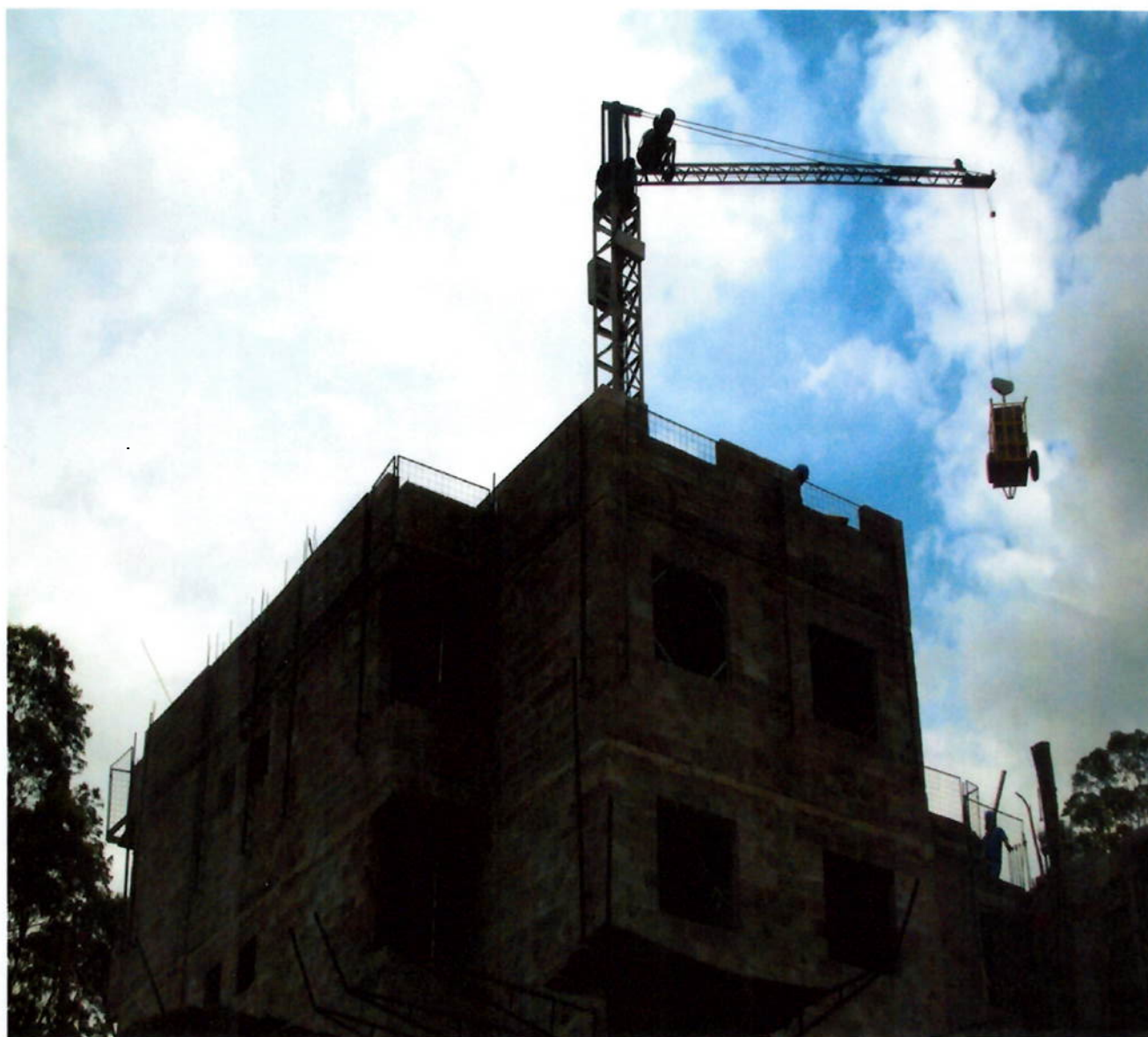
Figura 53 - Içamento pela mini-grua de carrinho de blocos (fonte: Arquivo Schahin)
