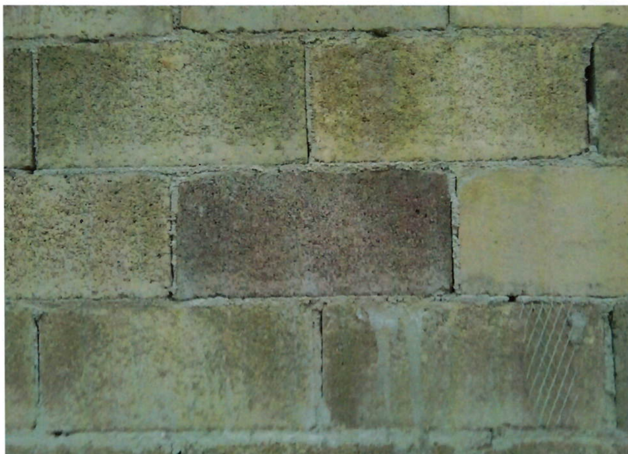
Figura 92 - Bloco de cor vermelha inserido em parede de blocos com cor amarela (fonte: arquivo Schahin)
