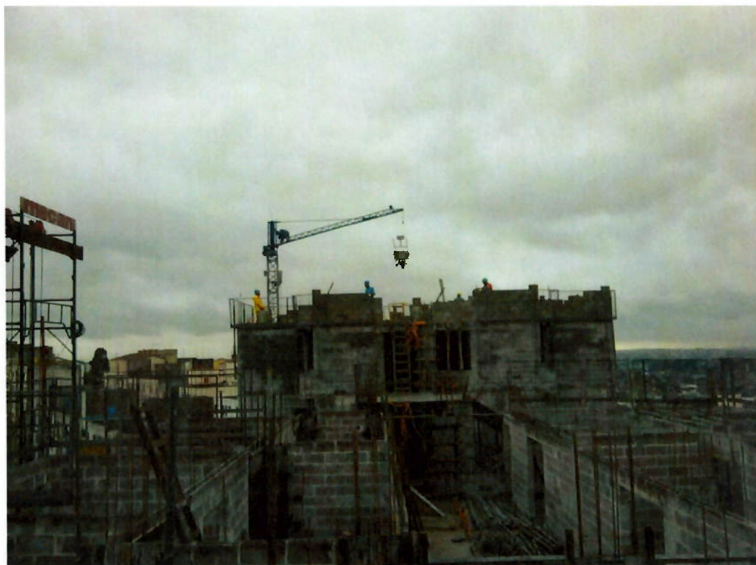
Figura 52 - Içamento pela mini-grua de carrinho de graute (fonte: Arquivo Schahin)
