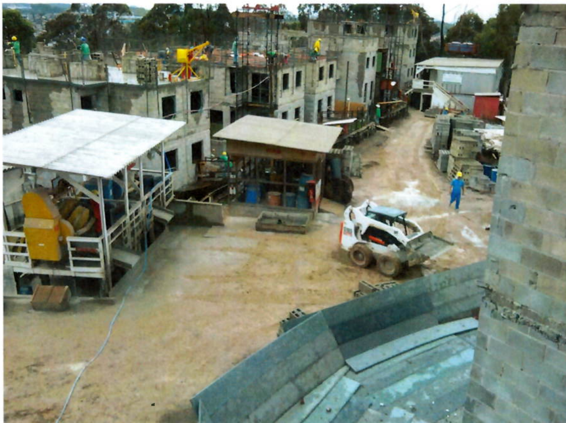
Figura 41 - Bob Cat levando argamassa de assentamento na concha para abastecer prédio 05 (fonte: Arquivo Schahin)
