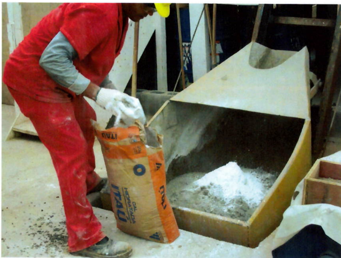
Figura 37 - Central de betoneiras – abastecimento pelo operário no nível do piso (fonte: Arquivo Schahin)
