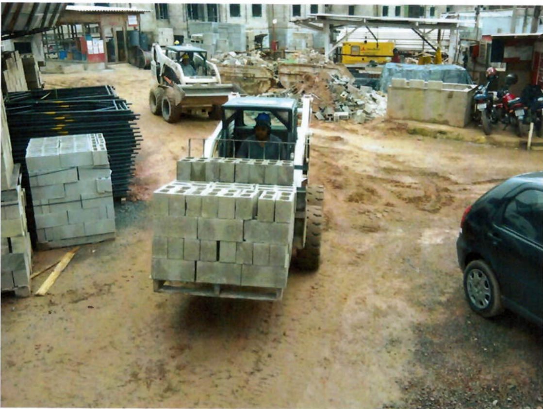
Figura 43 - Bob Cat 's carregando blocos e graute para abastecer prédio 05 (fonte: Arquivo Schahin)
