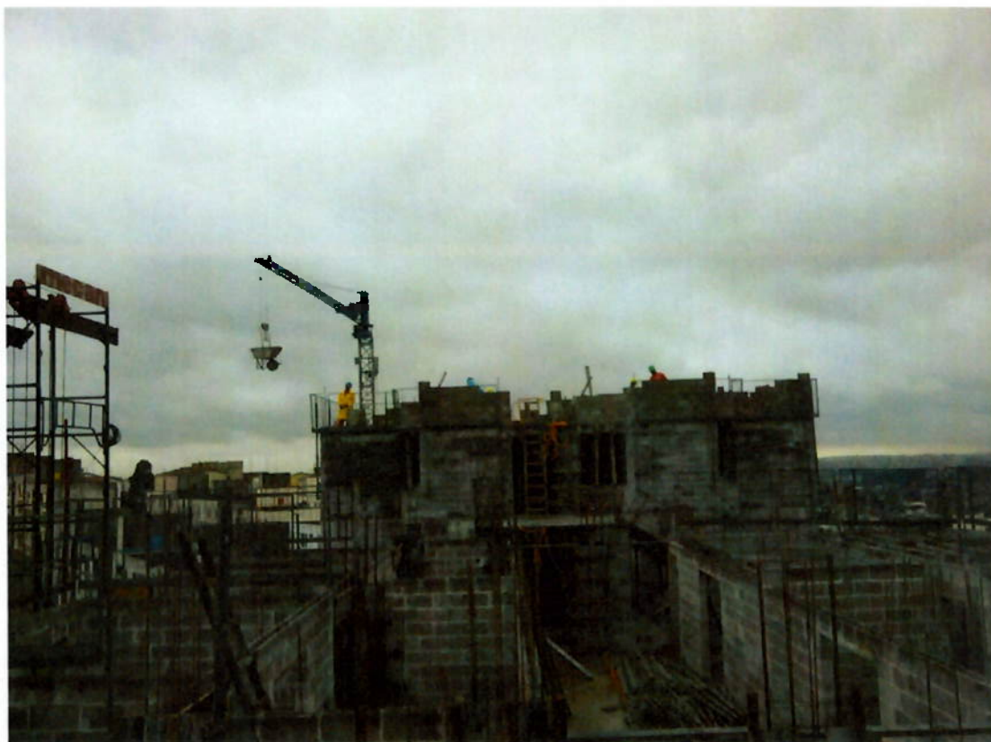
Figura 51 - Içamento pela mini-grua de carrinho de graute (fonte: Arquivo Schahin)
