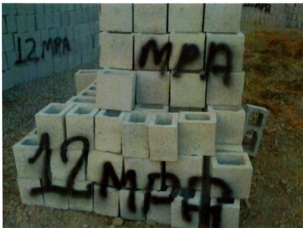
Figura 59 - Foto de estoque de bloco em obra – identificação com tinta “spray” (fonte: Eng. José Carlos de S. Leme Jr.)
