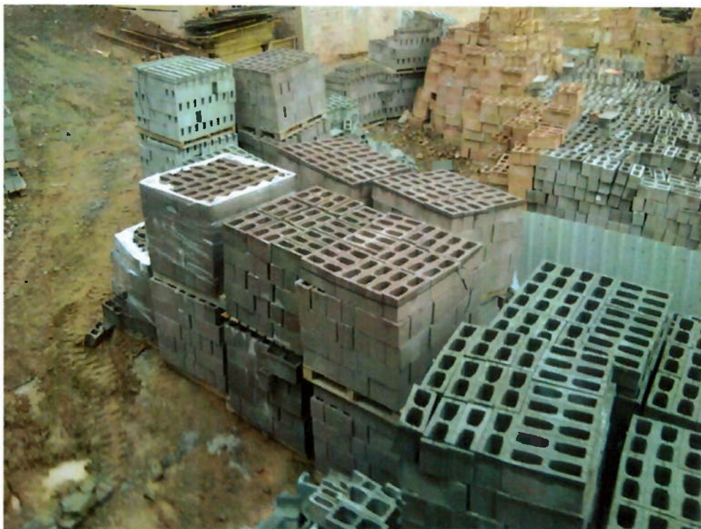
Figura 88 - Palletes de blocos coloridos estocados em canteiro de obra (fonte: arquivo Schahin)
