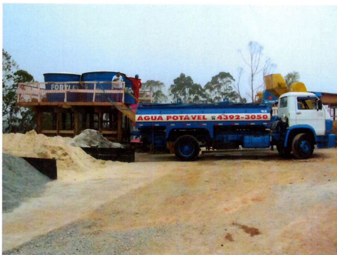
Figura 38 - Central de betoneiras – abastecimento com caminhão pipa em dia de falta de água (fonte: Arquivo Schahin)
