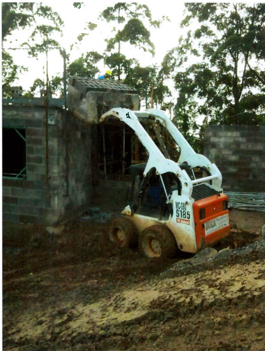
Figura 39 - Bob Cat abastecendo com blocos um dos pavimentos do prédio 05 (fonte: Arquivo Schahin)
