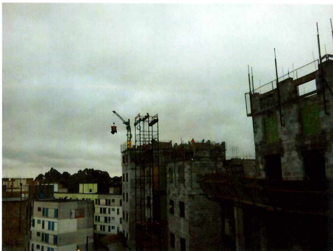
Figura 49 - Içamento pela mini-grua de carrinho de blocos (fonte: Arquivo Schahin)
