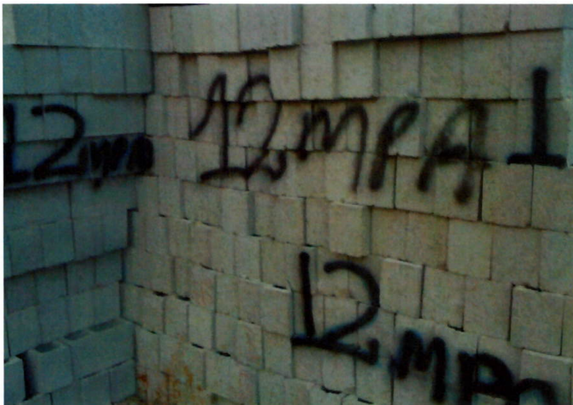
Figura 58 - Foto de estoque de bloco em obra – identificação com tinta “spray” (fonte: Eng. José Carlos de S. Leme Jr.)
