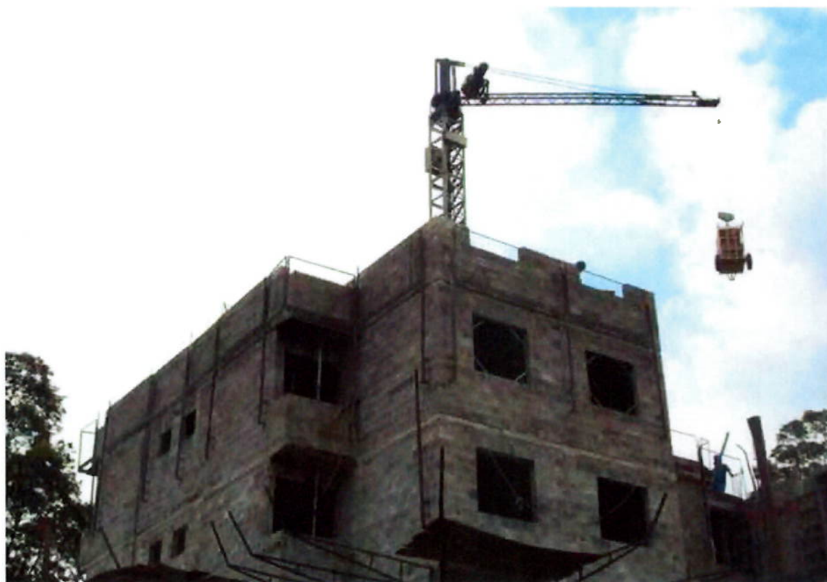
Resistências dos blocos e, consequentemente as cores, variam de acordo com as especificações do projeto
