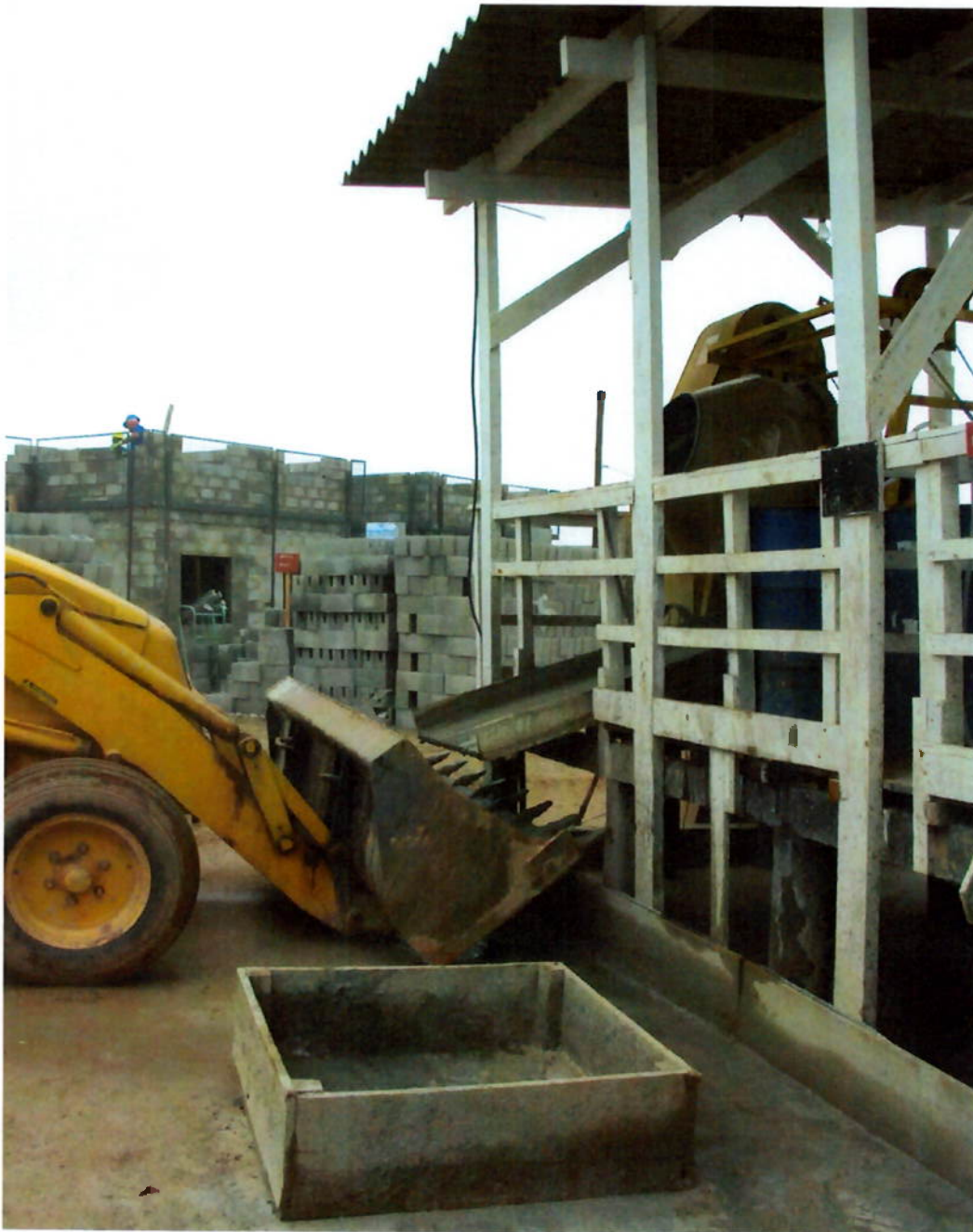
Figura 34 - Central de betoneiras – visão da concha da retroescavadeira pronta para carregar a mistura (fonte: Arquivo Schahin)
