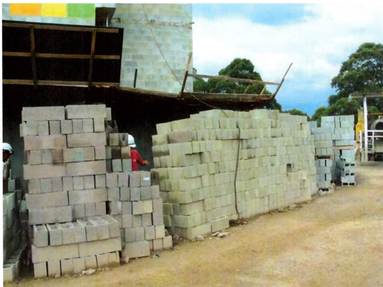
Resistência dos blocos varia de 4,5 MPa a 12 MPa
