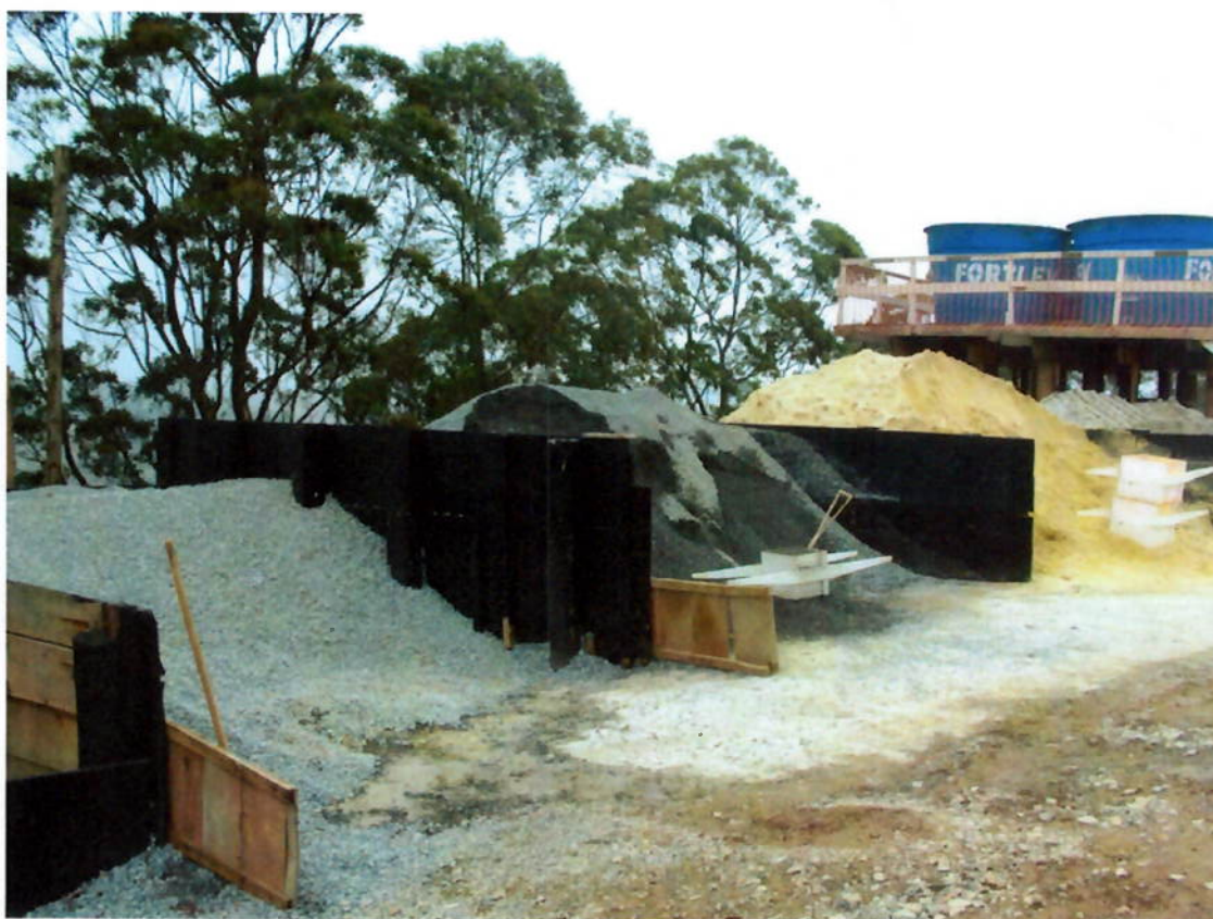
Figura 36 - Canteiro Administrativo – M. Virgem – baias de agregados na central de betoneiras (fonte: Arquivo Schahin)
