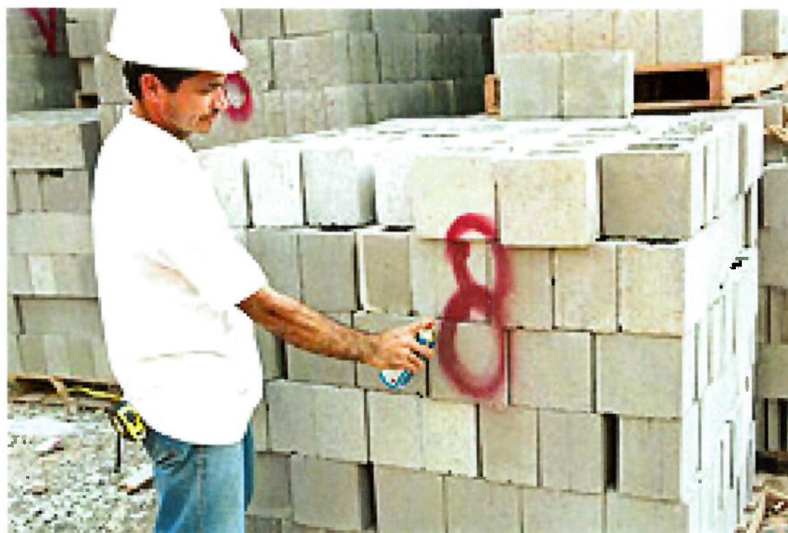
Figura 63 - Foto de estoque de bloco em obra – identificação com tinta “spray” (fonte: Revista Técnica – outubro/2010)
