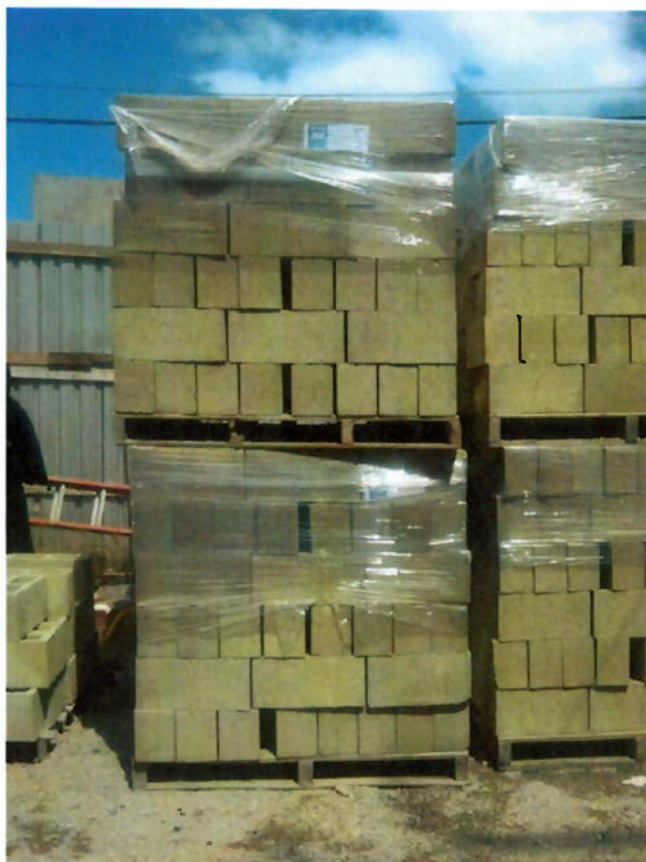
Figura 87 - Paletes de blocos coloridos estocados em canteiro de obra (fonte: arquivo Schahin)
