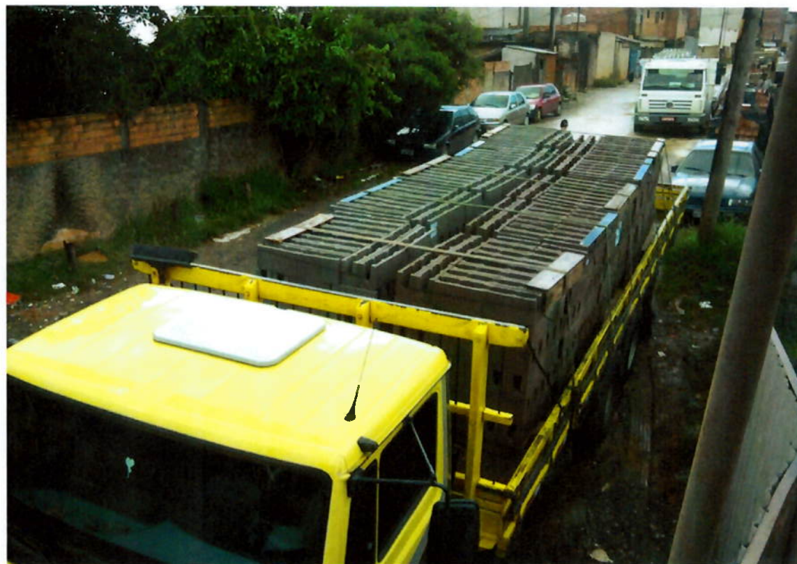
Figura 85 - Caminhão chegando à obra com carga de dois blocos de duas resistências (fonte: arquivo Schahin)
