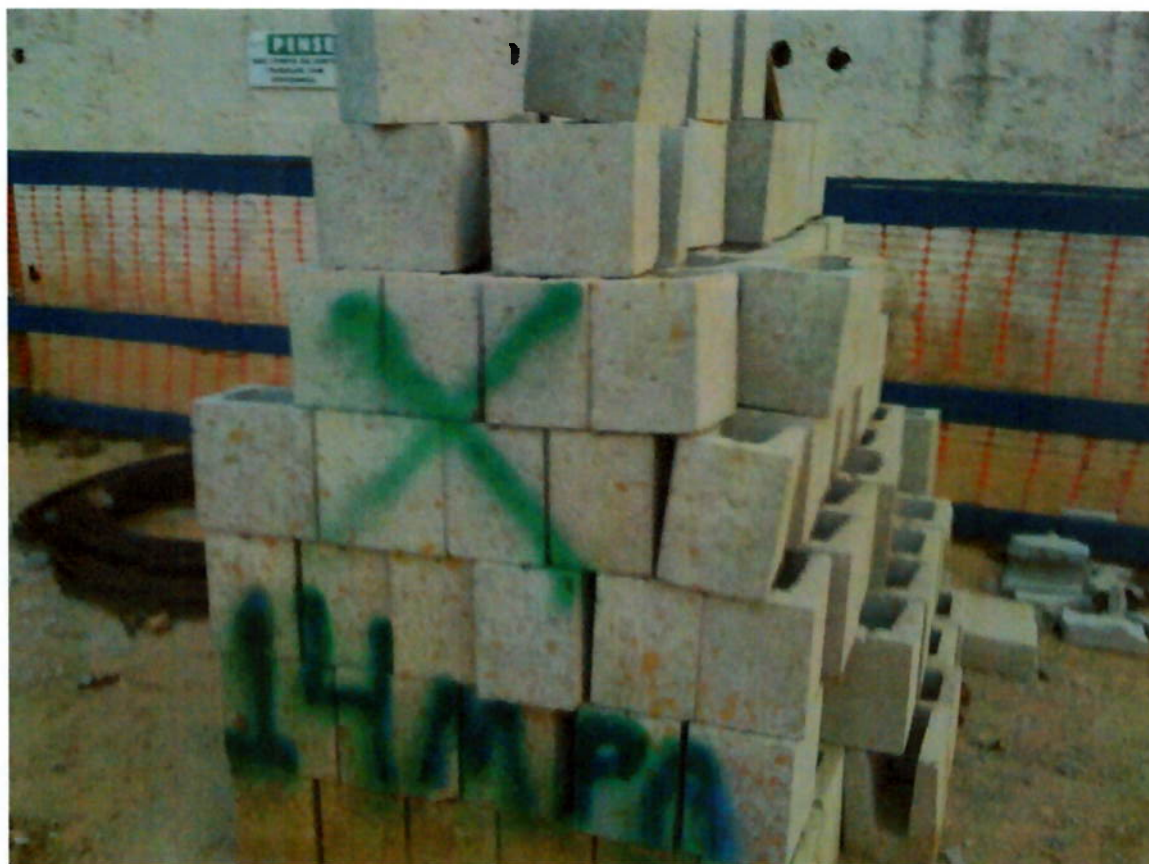
Figura 62 - Foto de estoque de bloco em obra – identificação com tinta “spray” utilizando critério de cores para a tinta conforme a resistência específica dos blocos (fonte: Eng. José Carlos de S. Leme Jr.)
