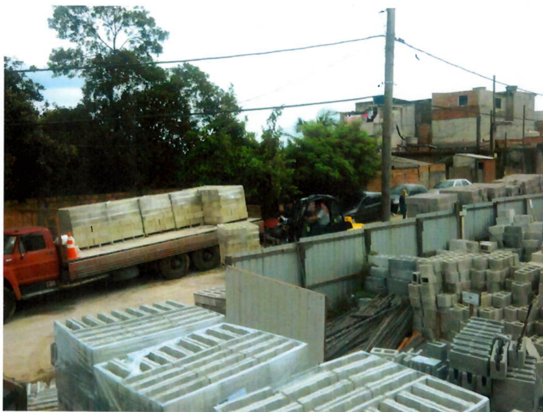
Figura 44 - Bob Cat descarregando pallet's de blocos diretamente do caminhão (fonte: Arquivo Schahin)
