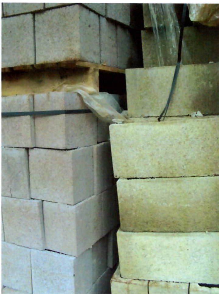
Figura 89 - Palletes de blocos coloridos estocados em canteiro de obra (fonte: arquivo Schahin)
