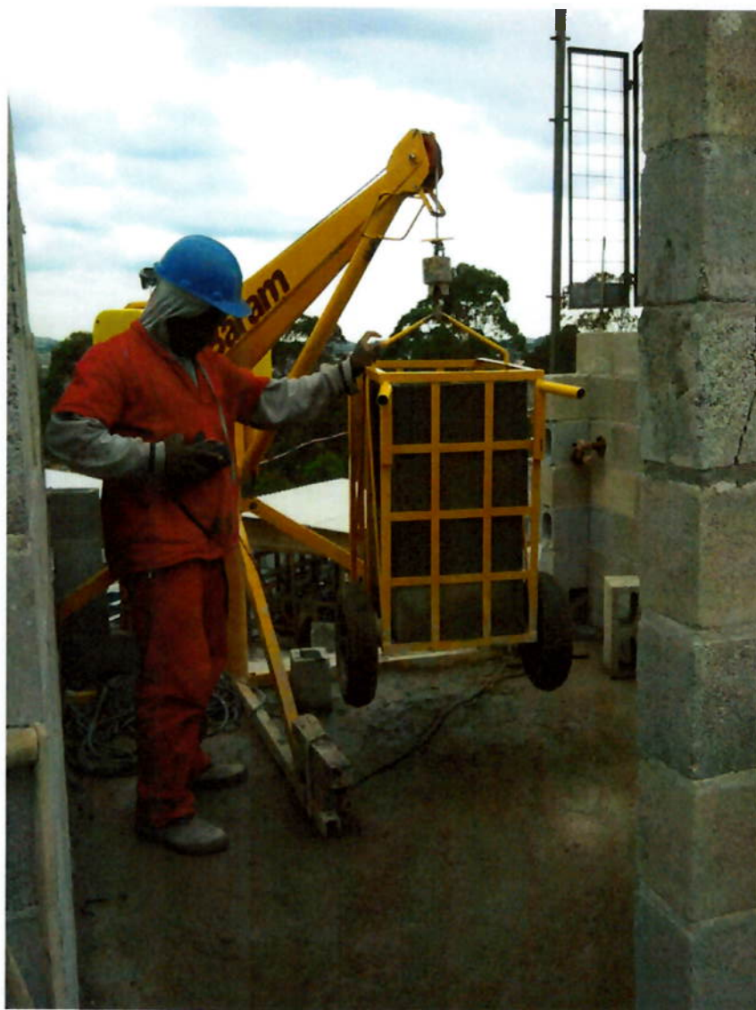
Figura 46 – Operário manobrando carrinho de blocos diretamente içado pela mini-grua (fonte: Arquivo Schahin)
