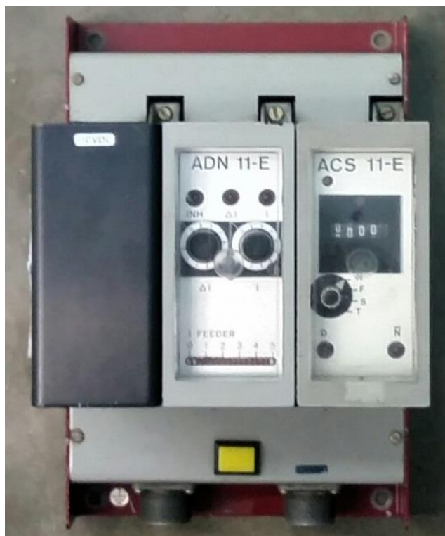
Figura 2 - Vista frontal do relé Detector de Defeito de Linha – DDL.
