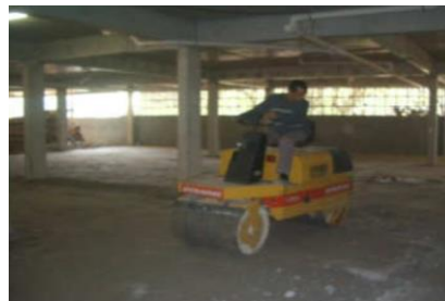
Foto de utilização de agregado reciclado para base de piso da garagem.
