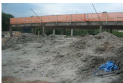
Foto de utilização de agregado reciclado para base de piso da garagem.
