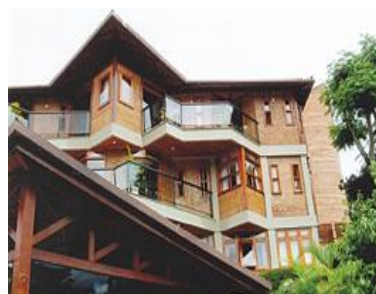
Utilização de bloco de solo cimento em habitação de alto padrão
